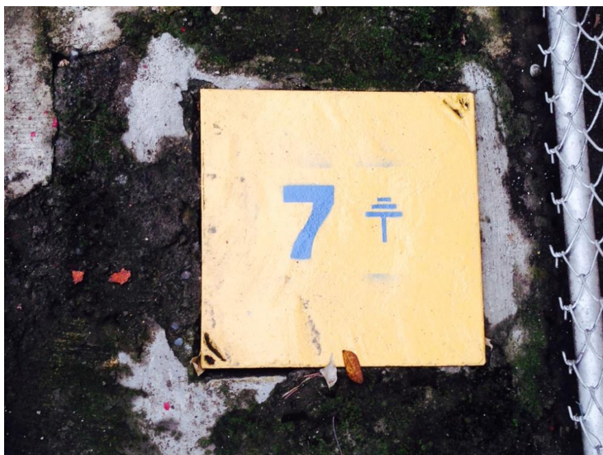
Figura 12. Tapa de electrodos (tapa de varilla de tierra para fácil revisión)
