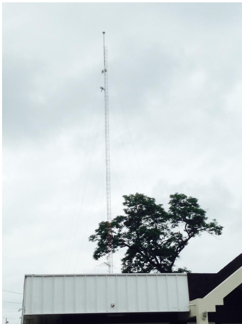
Figura 10. Pararrayos instalado en torre de comunicaciones (punto más alto de la planta)
