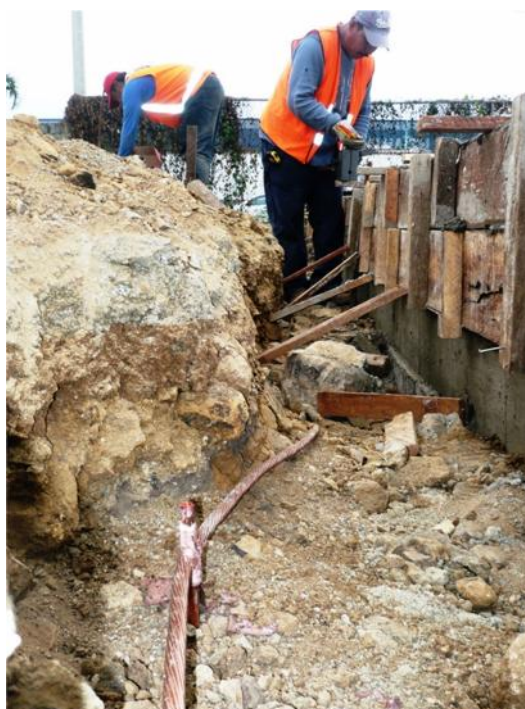
Figura 2. Instalación de la malla de tierra
