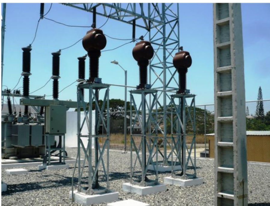
Figura 11. Montaje de equipos varios
