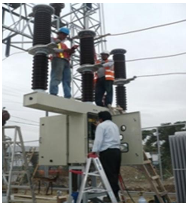
Figura 9. Montaje de interruptor de fuerza de 69 KV.
