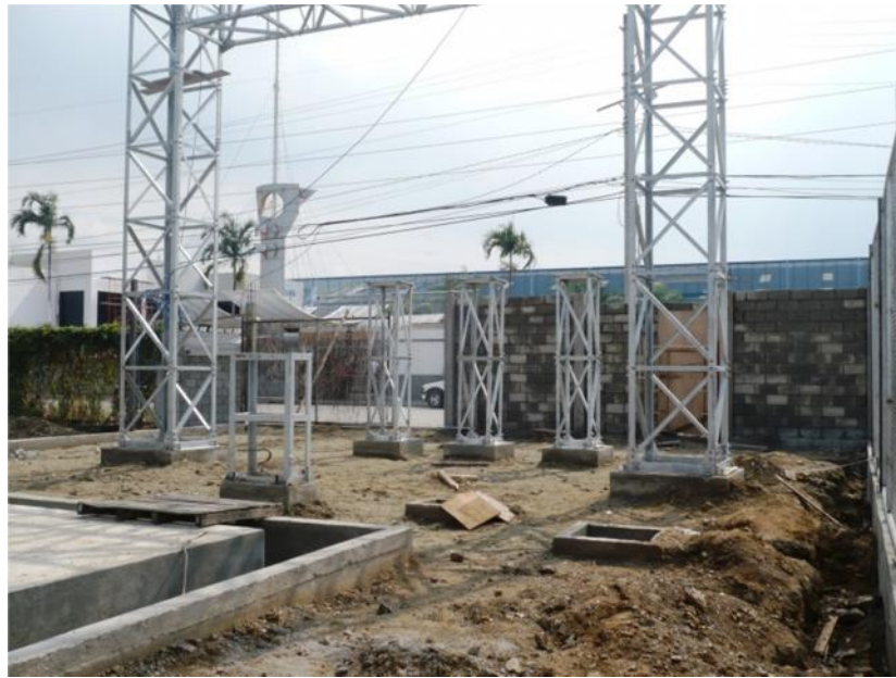
Figura 4. Montaje de pórticos varios de 69 KV.
