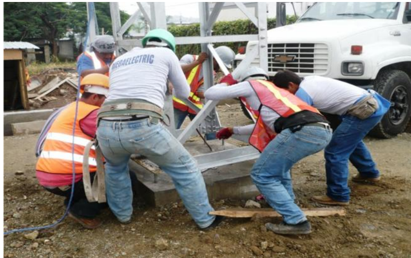
Figura 5. Montaje de columna de pórtico principal de 69 KV.
