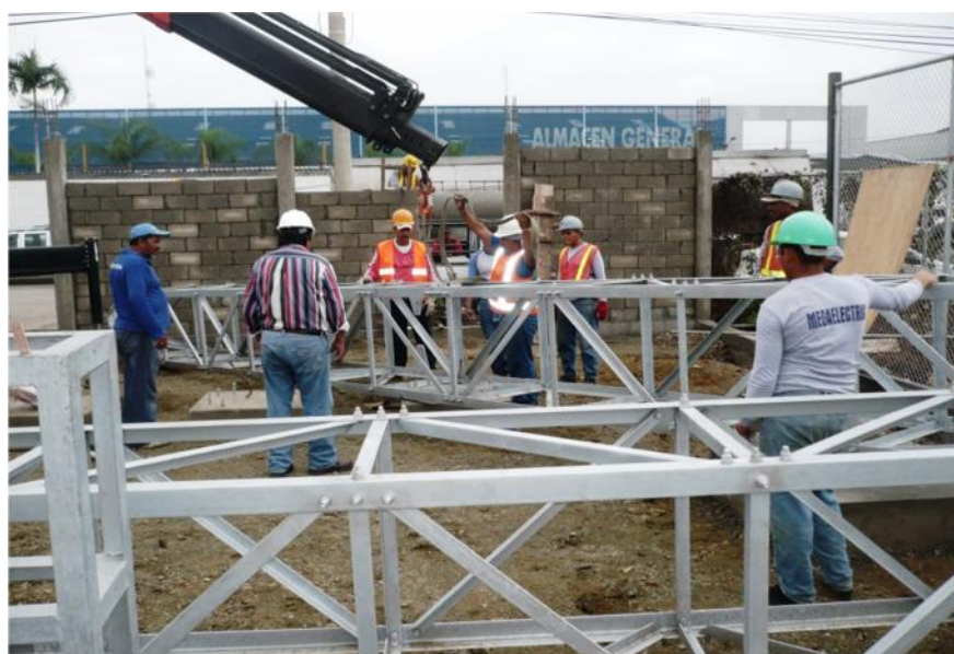
Figura 3. Montaje de pórtico principal de 69 KV
