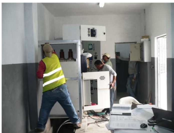
Figura 13. Montaje de celdas de 13.8 KV.
