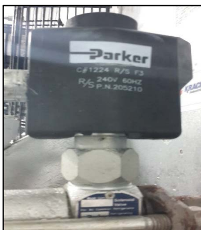
Figura 1.3: Válvula solenoide para paso de Amoniaco.
