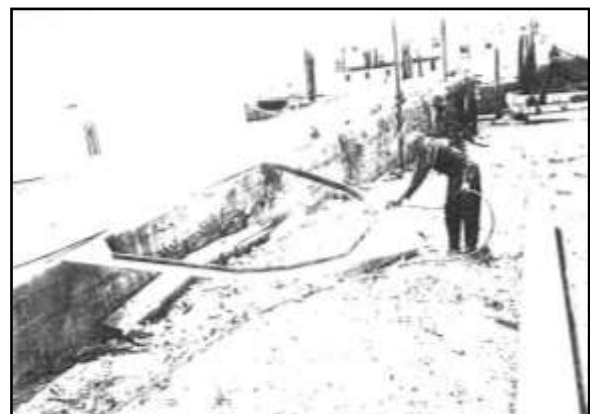
Figura 14. Protección anticorrosiva.
