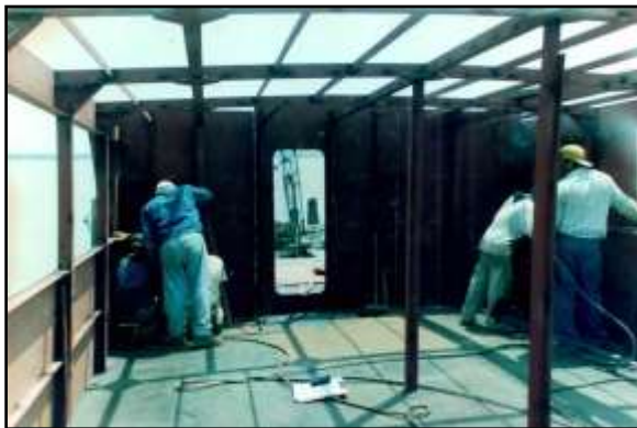
Figura 14. Planchaje del puente. Fuente: propia
