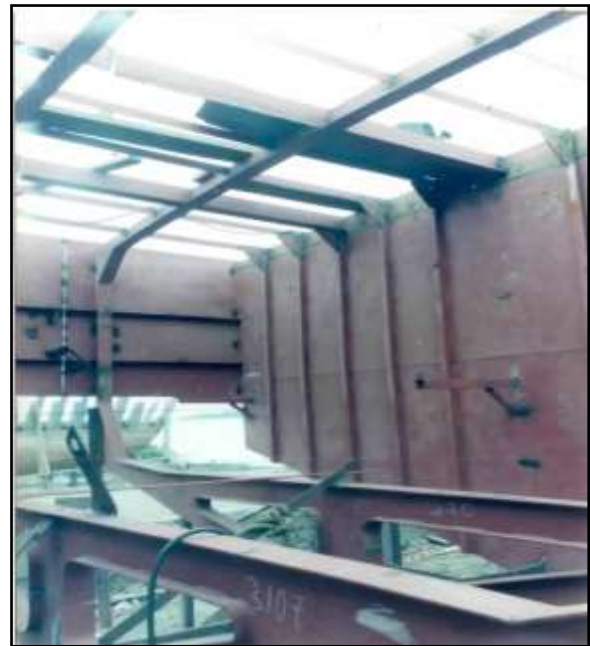
Figura 14. Colocación de planchas de costado. Fuente: propia
