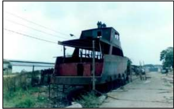
Figura 14. Termino de la construcción, vista de popa. Fuente: propia
