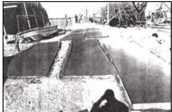
Figura 15. Limpieza y pintura de planchas.
