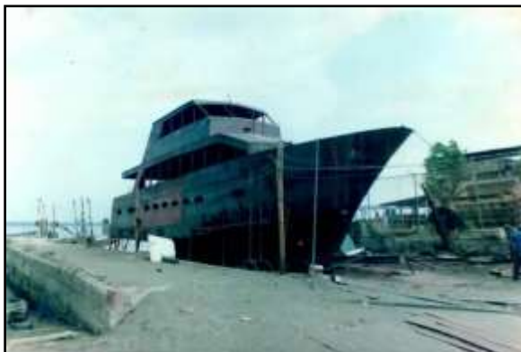
Figura 14. Termino de la construcción, vista proa. Fuente: propia
