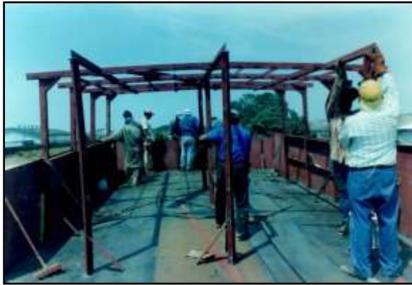
Figura 14. Estructura del puente de gobierno. Fuente: propia
