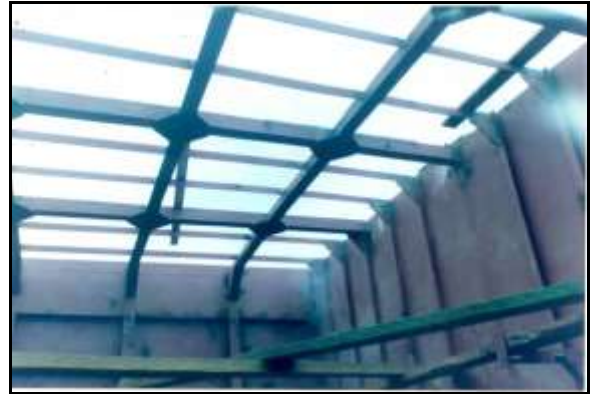
Figura 14. Colocación de baos y esloras. Fuente: propia
