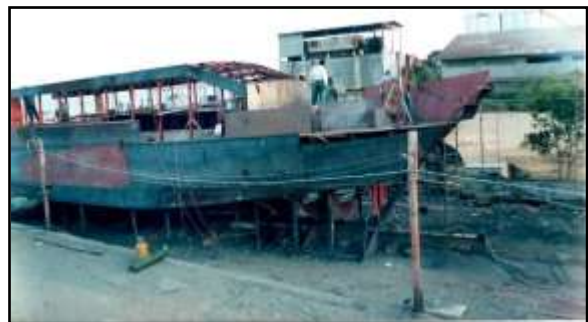
Figura 14. Superestructura y regala.
