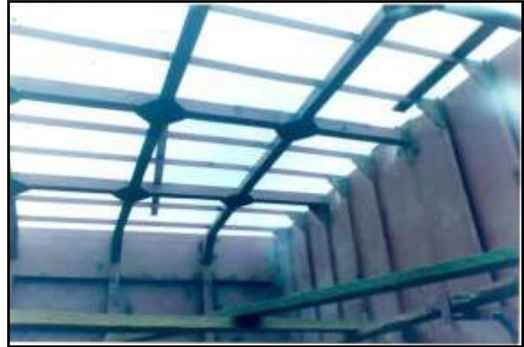
**Figura 14.** Colocación de baos y esloras.
