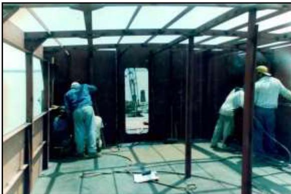
**Figura 14.** Planchaje del puente.
