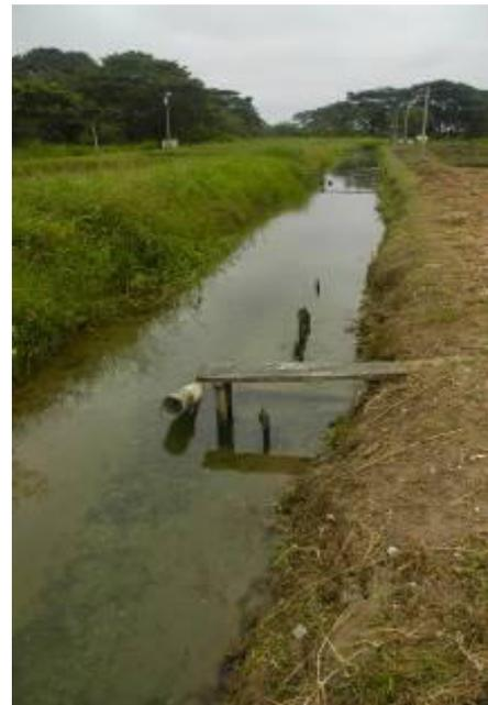
**Foto #03.-** Canal de abastecimiento con tubería PVC para permitir ingreso de agua.
