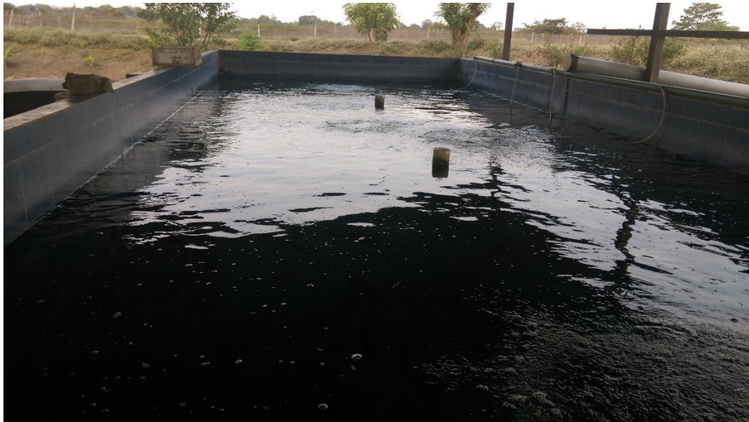
Figura 10. Piscina de Desaguado del Chame
