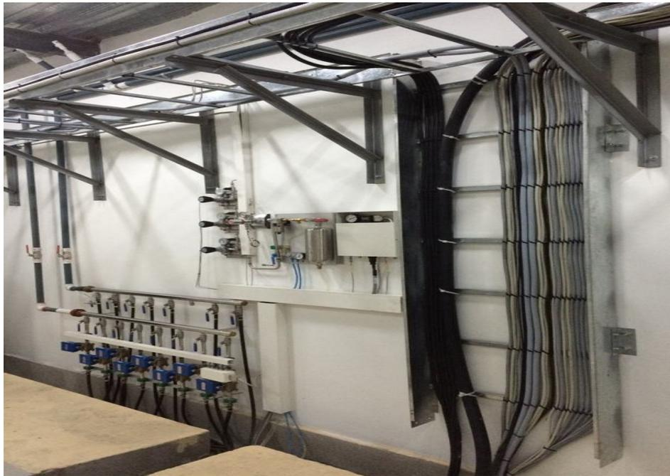
**Figura 1.5 Cableado en escalerilla**
