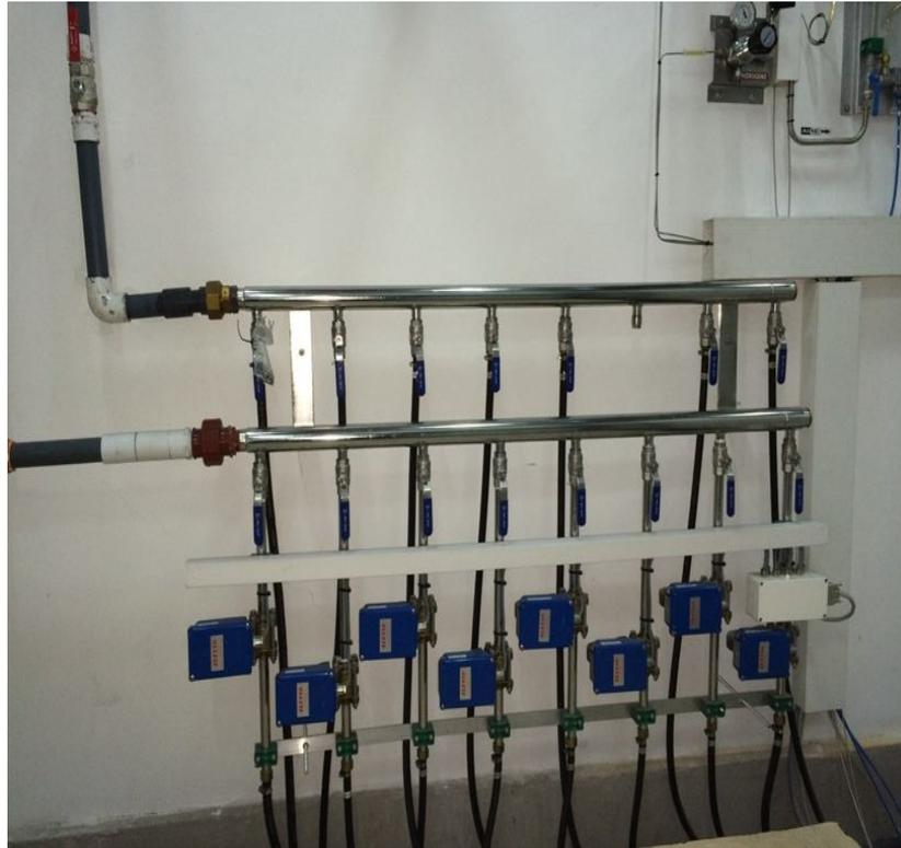
**Figura 1.6 Distribución de Válvulas de flujo**
