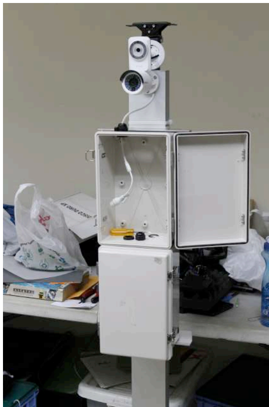
Figura 2.4 Montaje de cajas IP66 en la estructura soporte.
