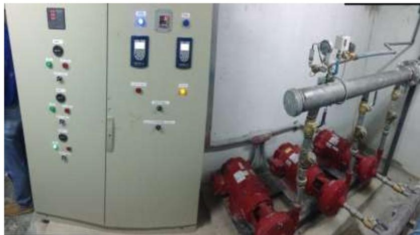
**Figura 2.2: Equipo de presión constante por velocidad variable**
