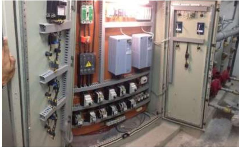
**Figura 2.1: Tablero de control para 3 bombas de 20HP con dos variadores, vista interior.**
