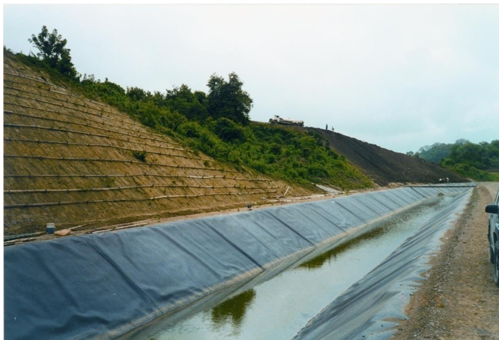
Fotografía 5: Canal Chongón – Sube y Baja Fuente: CEDEX
