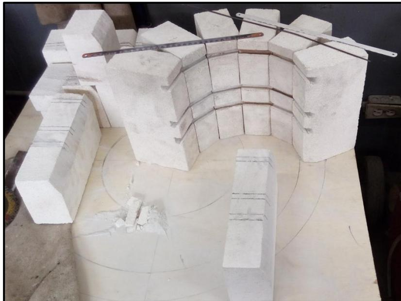
**Figura 3.8: Construcción de canales para las resistencias eléctricas**
