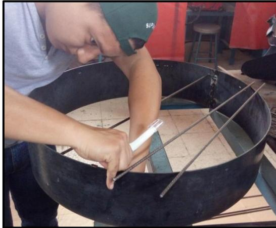
**Figura 3.28: Colocación de varillas corrugadas para el mallado**
