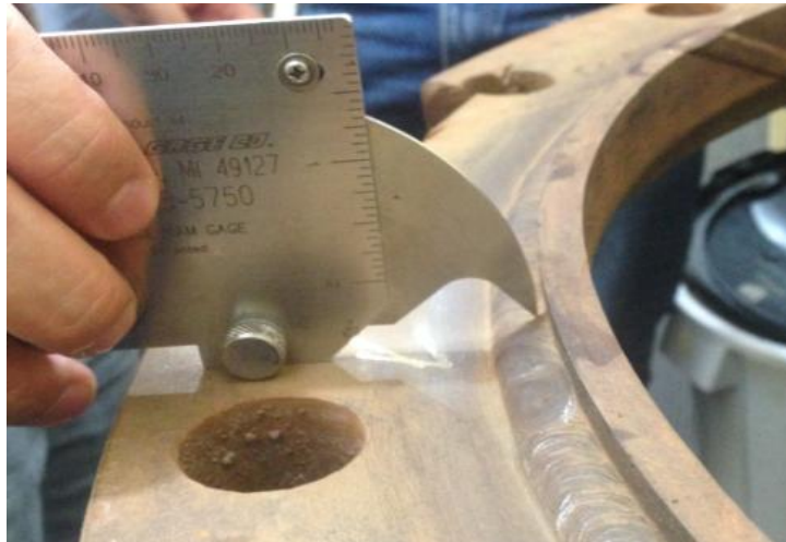
Figura 2.7 Medición del cordón de soldadura
