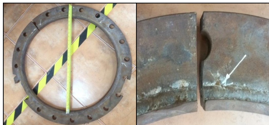
Figura 2.6 Sección de Brida con falla
