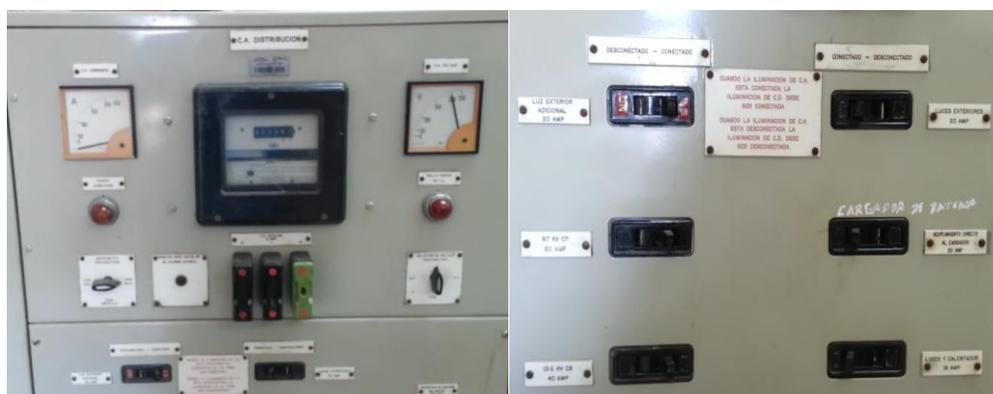
**Figura 1.22** Panel con los dispositivos de medición y protección A.C. y D.C.
