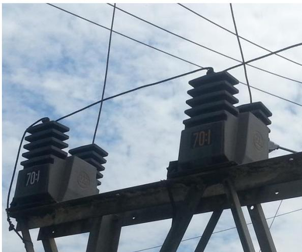
**Figura 1.17** Transformador de voltaje marca Westinghouse, relación 70:1
