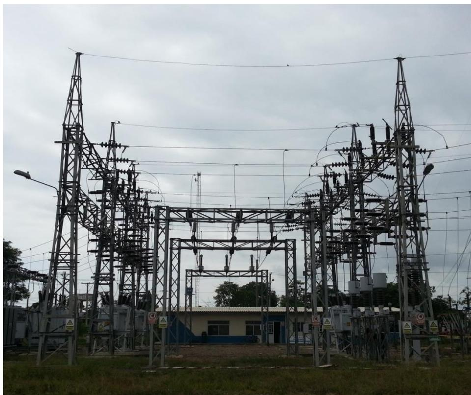
**Figura 1.3** Patio de maniobras a 69 KV de la subestación Machala.
