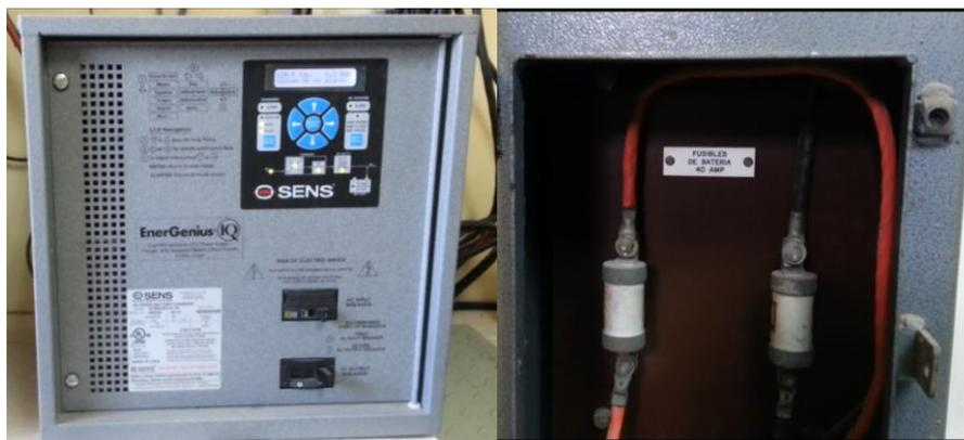
**Figura 1.21** Cargador y fusibles de protección del banco de baterías
