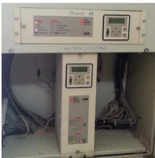
**Figura 1.24** Panel de control con los relés DPU 2000R
