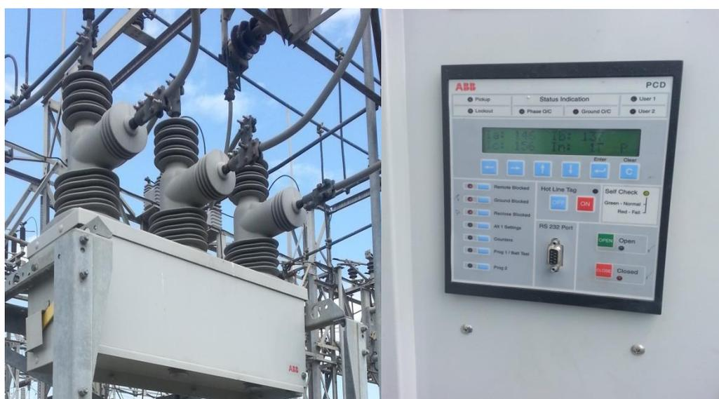
**Figura 1.14** Vista del reconectador ABB con su respectivo controlador
