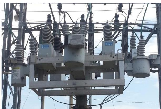
**Figura 1.19** Banco de Capacitores ubicados en la barra de 13,8 KV.
