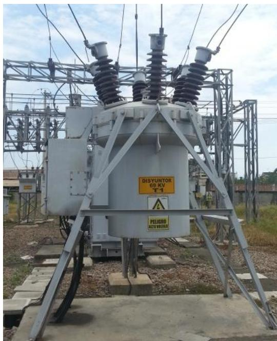
**Figura 1.7** Interruptor de 69 KV de la subestación Machala.
