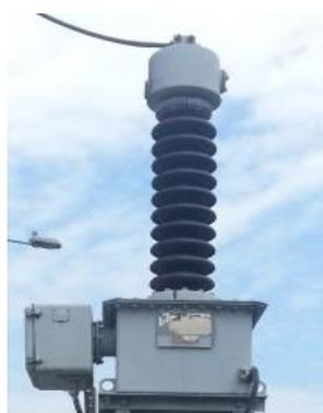
**Figura 1.9** Transformador de voltaje para 69 KV
