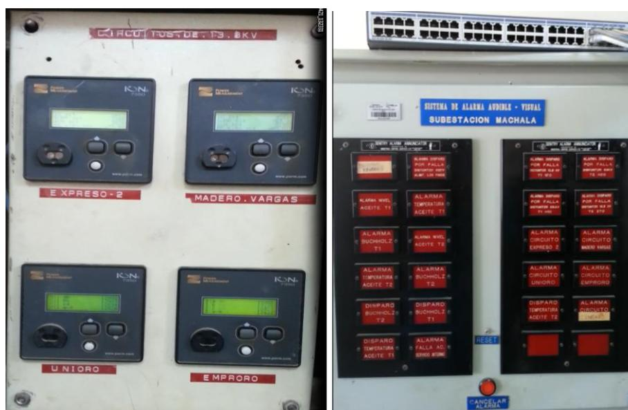
**Figura 1.23** Medidores ION 7350 y panel de alarma en la S.E. Machala
