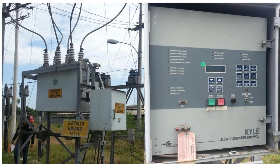
**Figura 1.13** Vista del reconectador Cooper con su respectivo controlador
