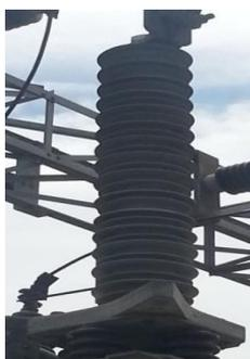
**Figura 1.8** Pararrayo de 69 KV, Subestación Machala
