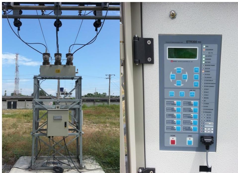
Figura 1.15 Vista del reanectador ENTEC con su respectivo controlador
