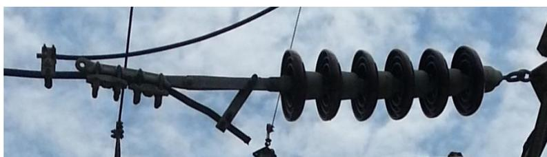
**Figura 1.6** Aisladores de 69 KV, Subestación Machala
