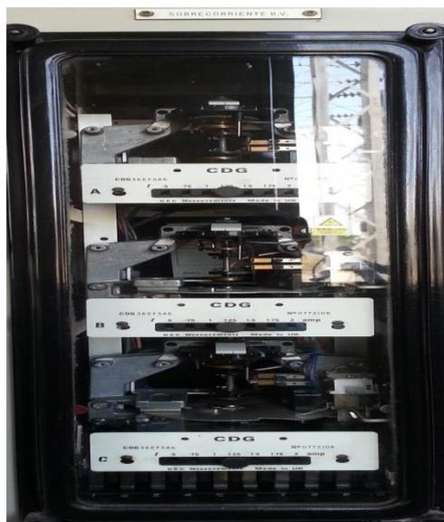
**Figura 1. 25** Relé de sobrecorriente marca G.E. en bajo voltaje para T1
