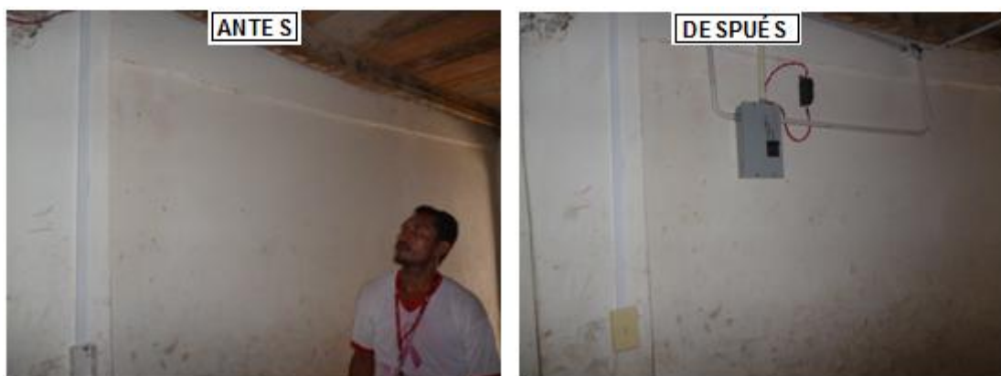
Figura 3. 50: Instalación de breaker principal y caja de breakers
