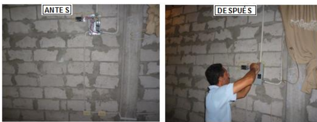
Figura 3. 57: Instalación de caja de breaker y tomacorrientes
