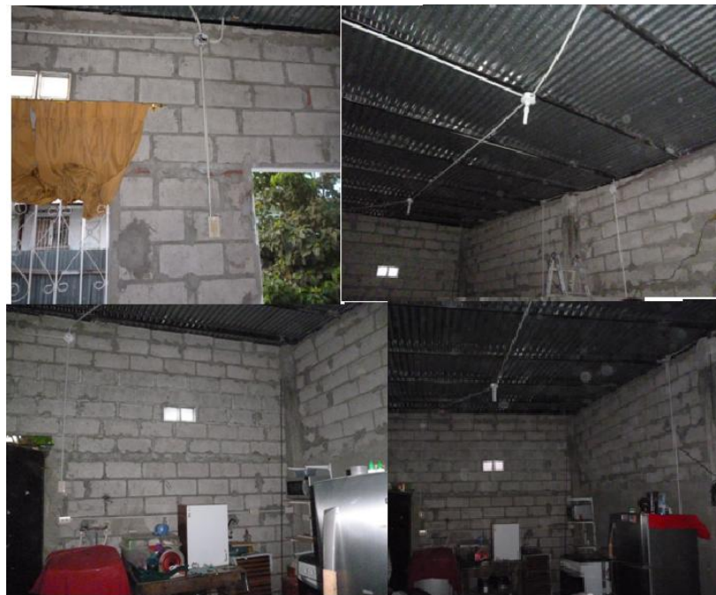
Figura 3. 38: Collage culminación instalaciones eléctricas
