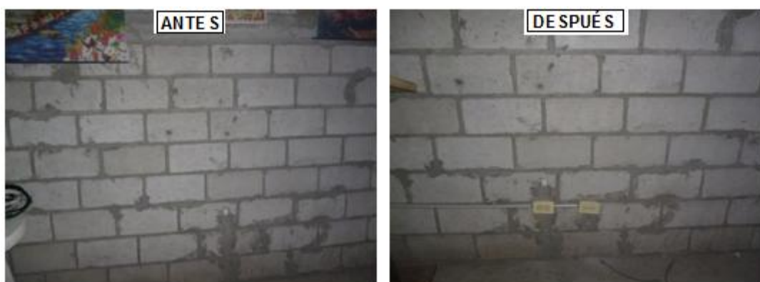
Figura 3. 56: Instalación de tomacorrientes de 120V
