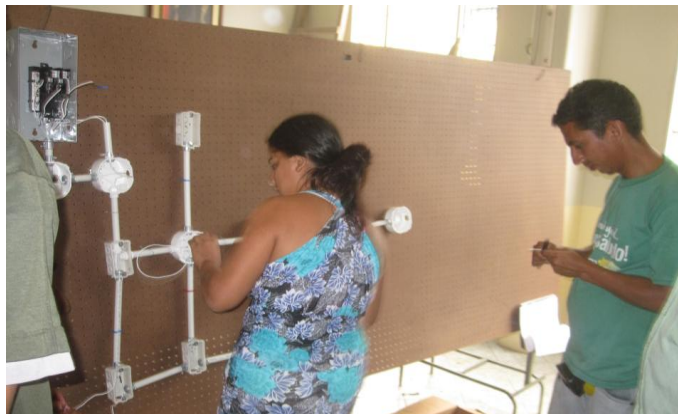
Figura 3. 11: Conexión en paralelo tomacorrientes de 120V
