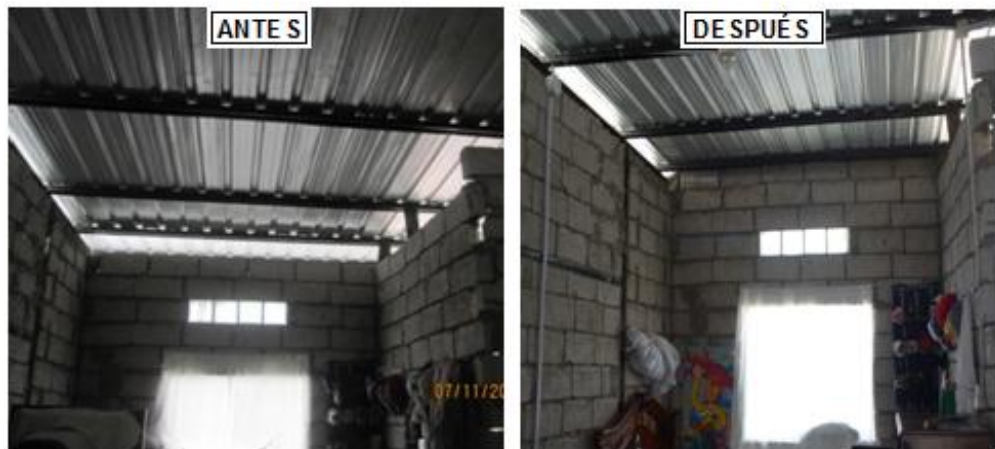
Figura 3. 30: Instalación de iluminarias en dormitorio
