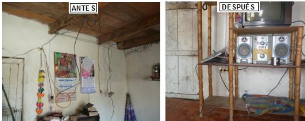
Figura 3. 49: Instalación de tomacorriente
