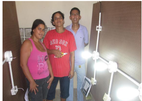
Figura 3. 9: Conexiones de alumbrado
