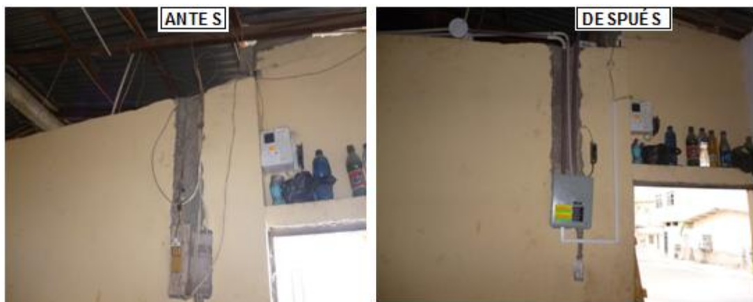
Figura 3. 40: Instalación de caja de breakers
