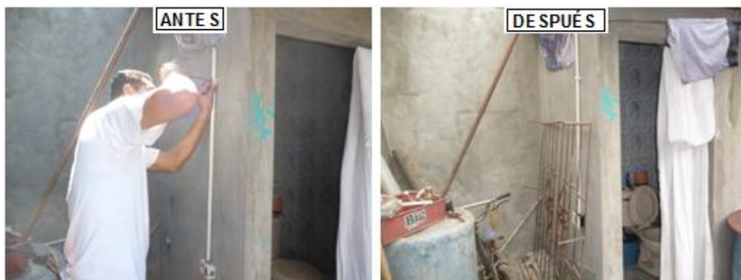
Figura 3. 46: Instalación de tomacorriente 120V para lavadora
