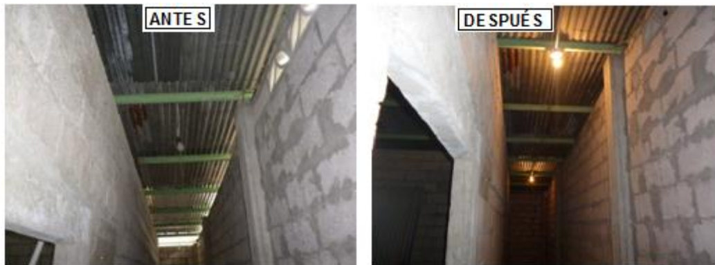
Figura 3. 55: Instalación de iluminarias en corredor
