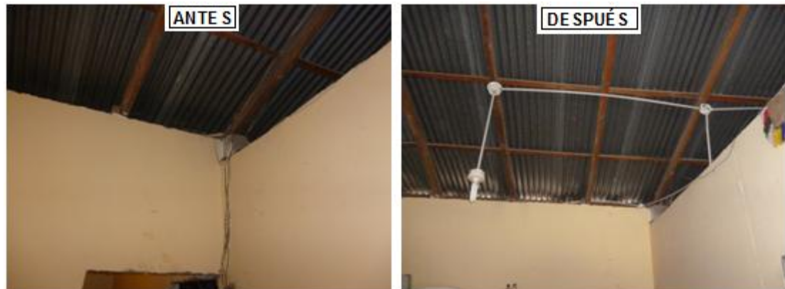
Figura 3. 42: Instalación de luminarias a través de tuberías
