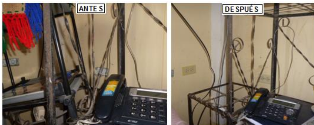
Figura 3. 43: Instalación de tomacorrientes en cajas rectangulares
