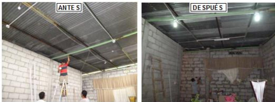
Figura 3. 54: Instalación de iluminarias
