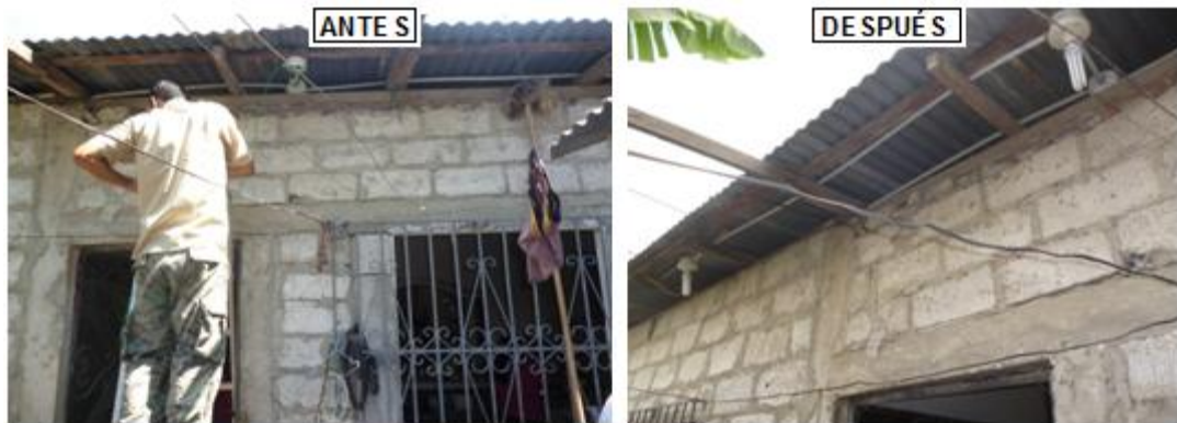
Figura 3. 45: Instalación de luminarias en patio
