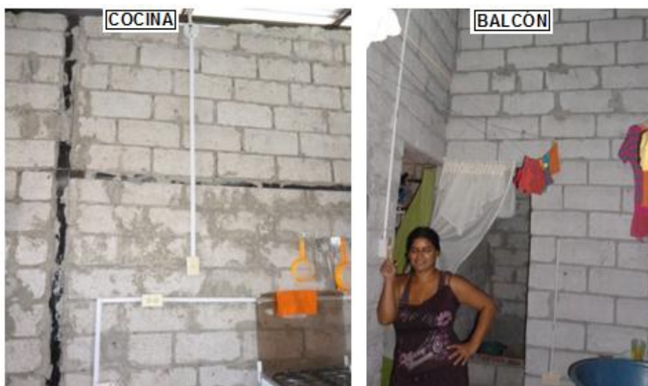
Figura 3. 32: Culminación de instalaciones eléctricas
