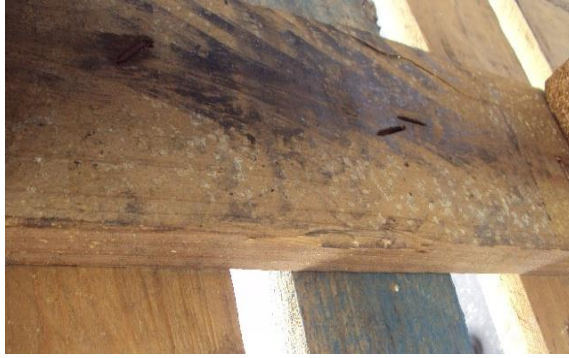
Figura 2.9 Ejemplo de contaminación por Hongo
