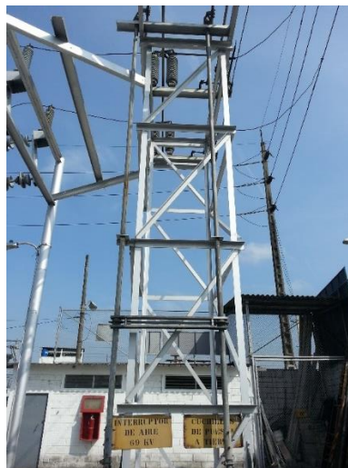
Figura 1.4 Seccionador tripolar de aire con cuchillas de tierra.
