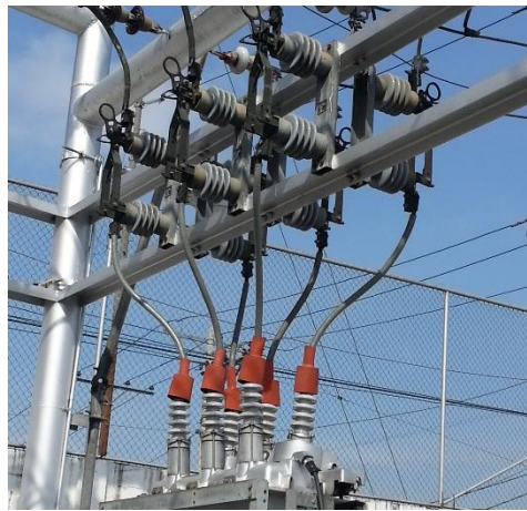
Figura 1.11 Cuchillas seccionadoras 600 [A].
