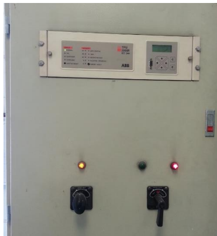
Figura 1.15 Panel de control con el relé TPU2000R.
