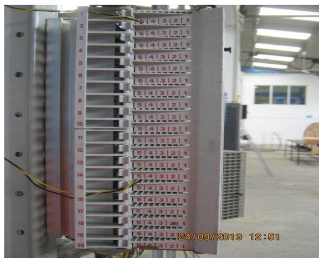
Figura 3.14 Bloques De Conexión
