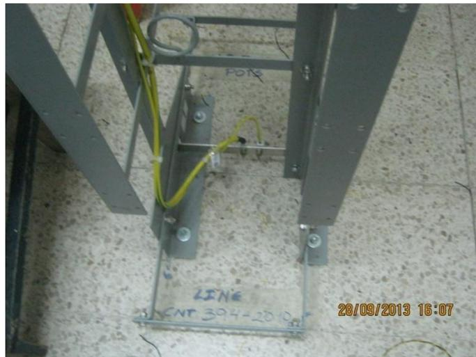
Figura 3.18 Conexión a Tierra de MDF en Central Lago Capeira
