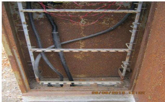
Figura 4.3 Armario 02 sin conexión a tierra
