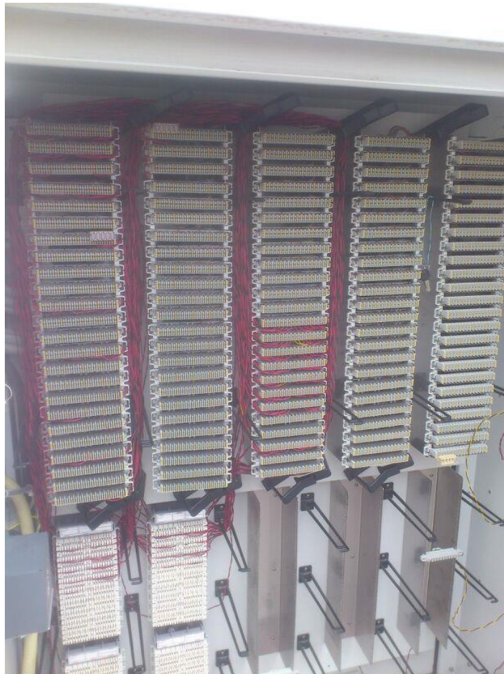
Fig. 4.7 Regletas de repartidor del mini nodo en Pto. Seymour.
