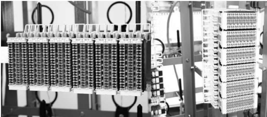
Fig. 4. 26 Módulo BRCP-SP de uso Vertical y Horizontal. [24]
