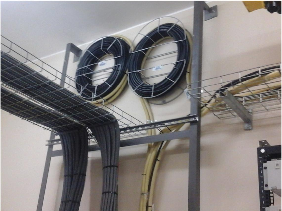
Fig. 5.18 Cable eKkx y Fibra Óptica
