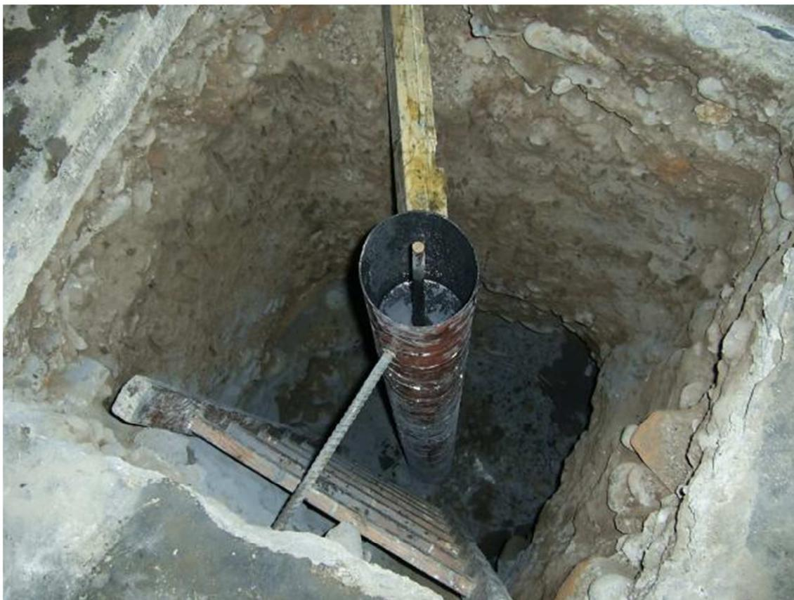
Fig. 5.19 Realización de una Conexión a Tierra
