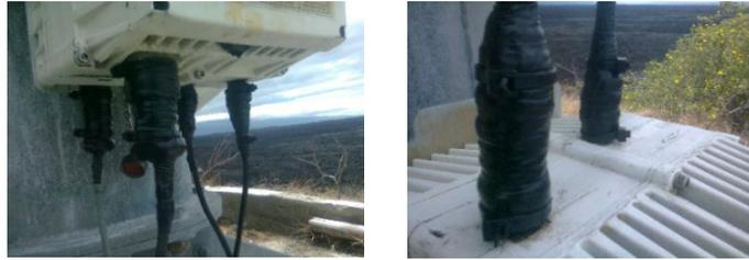
Figura 3. 17: Mantenimiento a conectores de transceptores.
