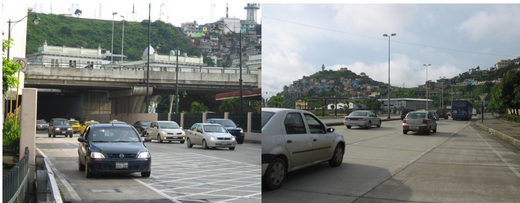
Tráfico vehicular a la entrada-salida del túnel del cerro El Carmen
