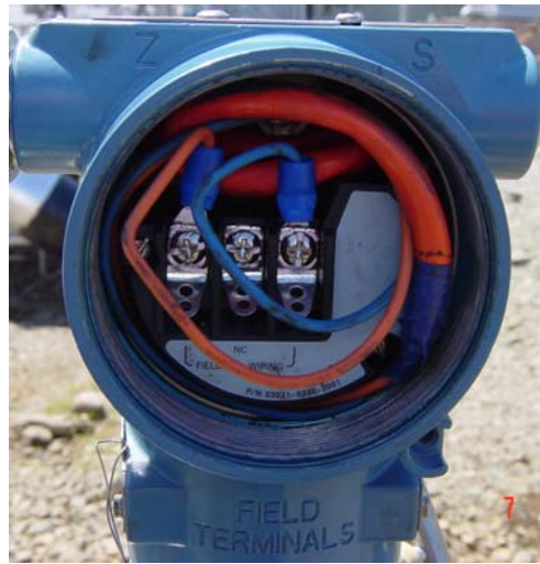
Conexión Transmisor de Presión
