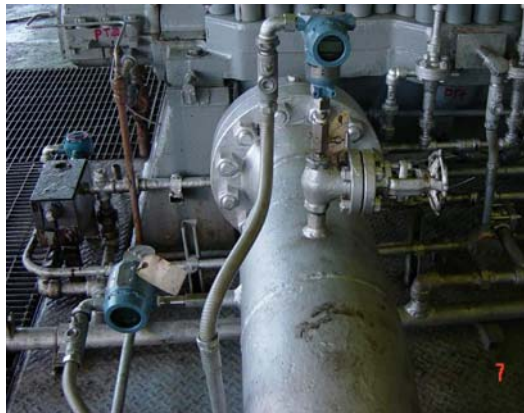
Instrumentos Succión de la Bomba
