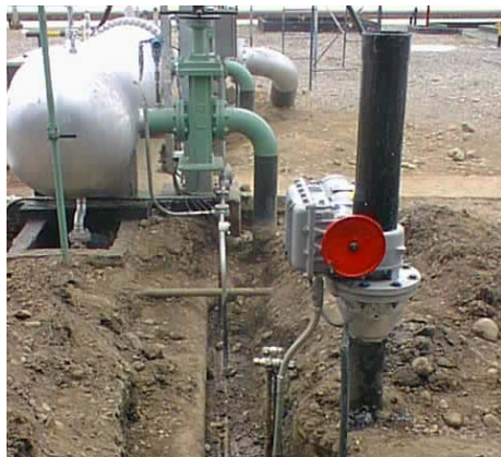
Actuador de Descarga
