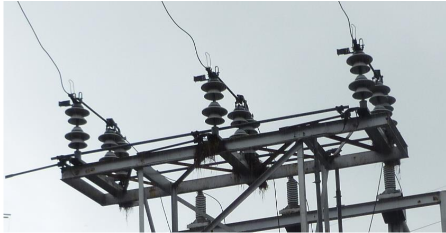
Figura 1.5 Seccionador Tripolar de Aire con cuchillas de Tierra
