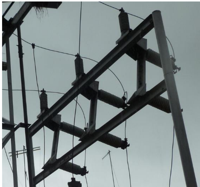
Figura 1.4 Aisladores 69 KV
