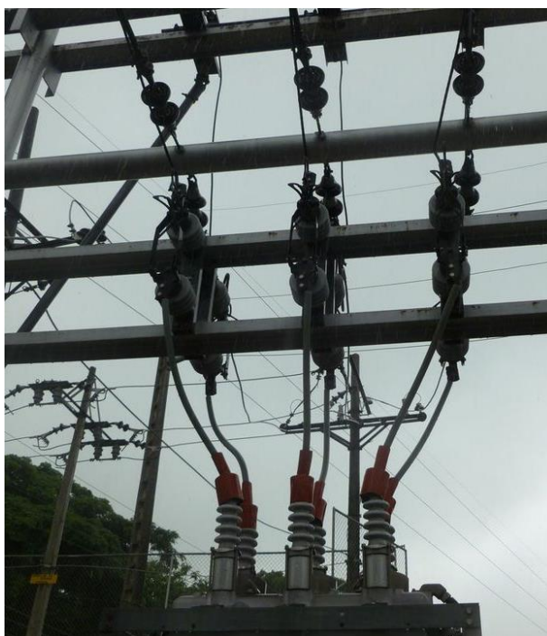
Figura 1.12 Cuchillas seccionadoras monofásicas 600 A.
