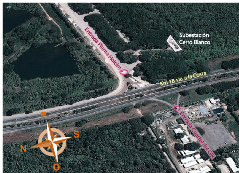
Figura 1.2 Vista Satelital - Subestación CERRO BLANCO
