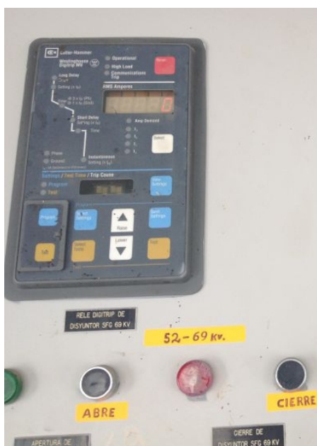
Fig. 1.7Relé Cutler Hammer Digitrip MV
