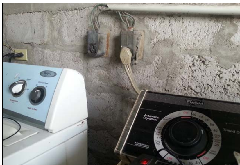
Figura 4.15. Conector hembra para dispositivos a 220 V
