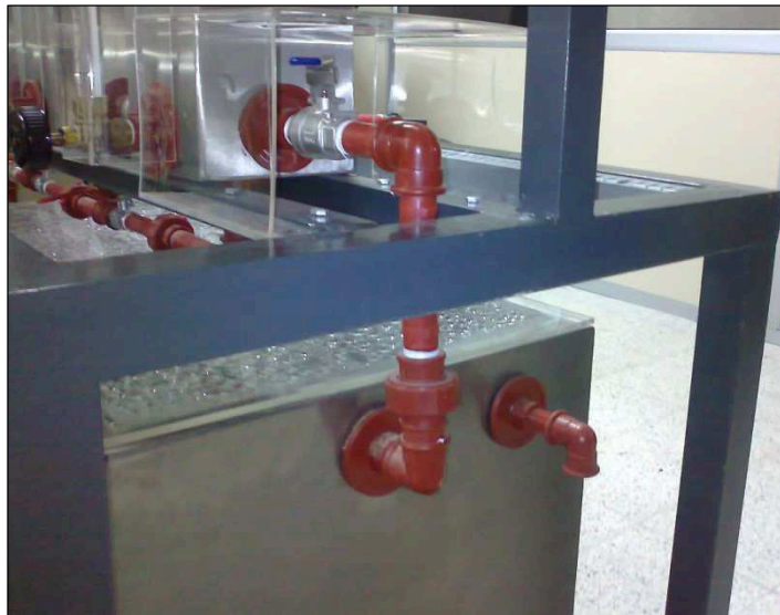
Figura 1.11. Vista del Retorno del Tercer Tanque al Reservorio
