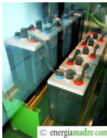
Figura 2.7 Conexión de baterías. Fuente: [12].
