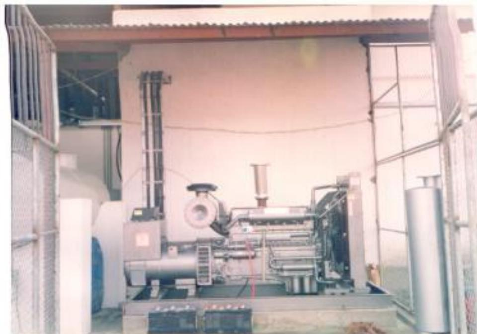
FIGURA 5.13 GENERADOR DE EMERGENCIA
