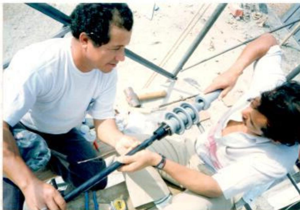
FIGURA 5.2 - PUNTAS TERMINALES EXTERIORES
