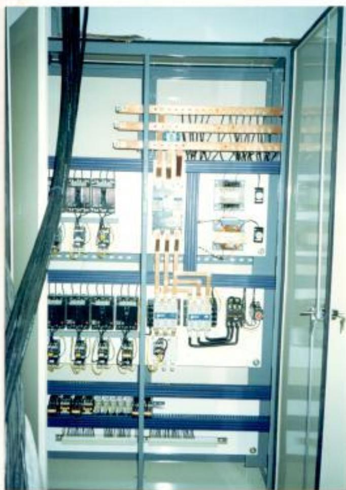
FIGURA 5.7 CENTRO DE CONTROL DE MOTORES
