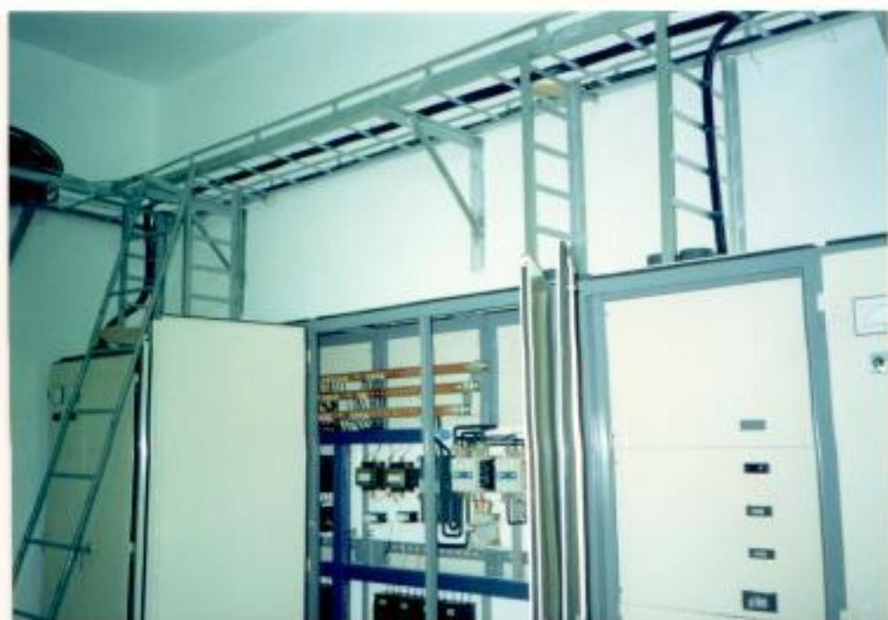
FIGURA 5.10 ELECTROCANALES SOBRE TABLEROS
