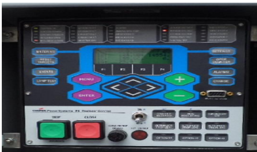
Figura #5. 3 Reconectador COOPER Forma 6 VWE.
