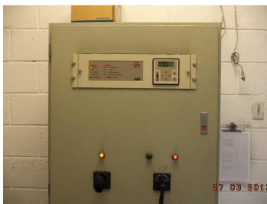
Figura #1. 29 Tablero del TPU 2000R
