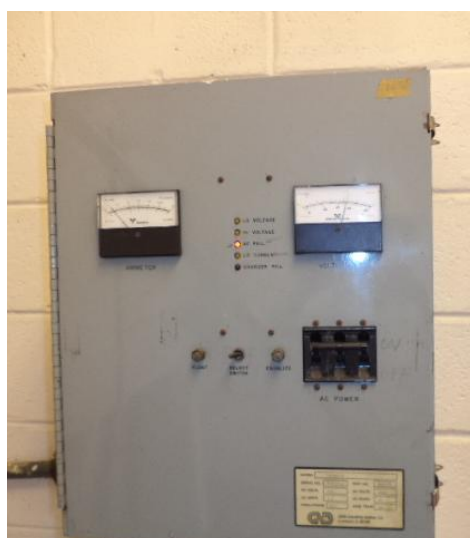
Figura #1. 25 Cargador de baterías
