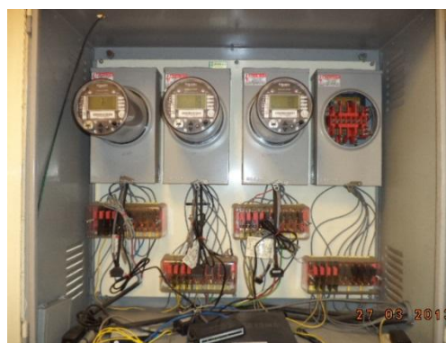
Figura #1. 27 Medidores alimentadoras
