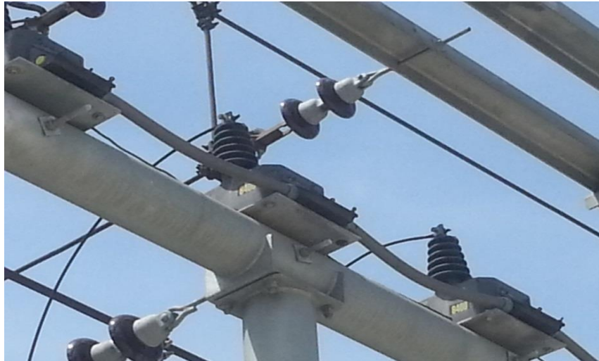
Figura 1. 12 Transformador De Potencial
