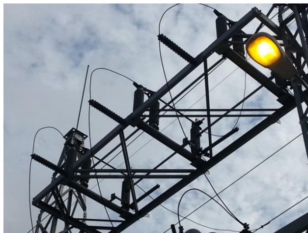
Figura 1. 2 Seccionador tripolar motorizado con cuchillas de tierra
