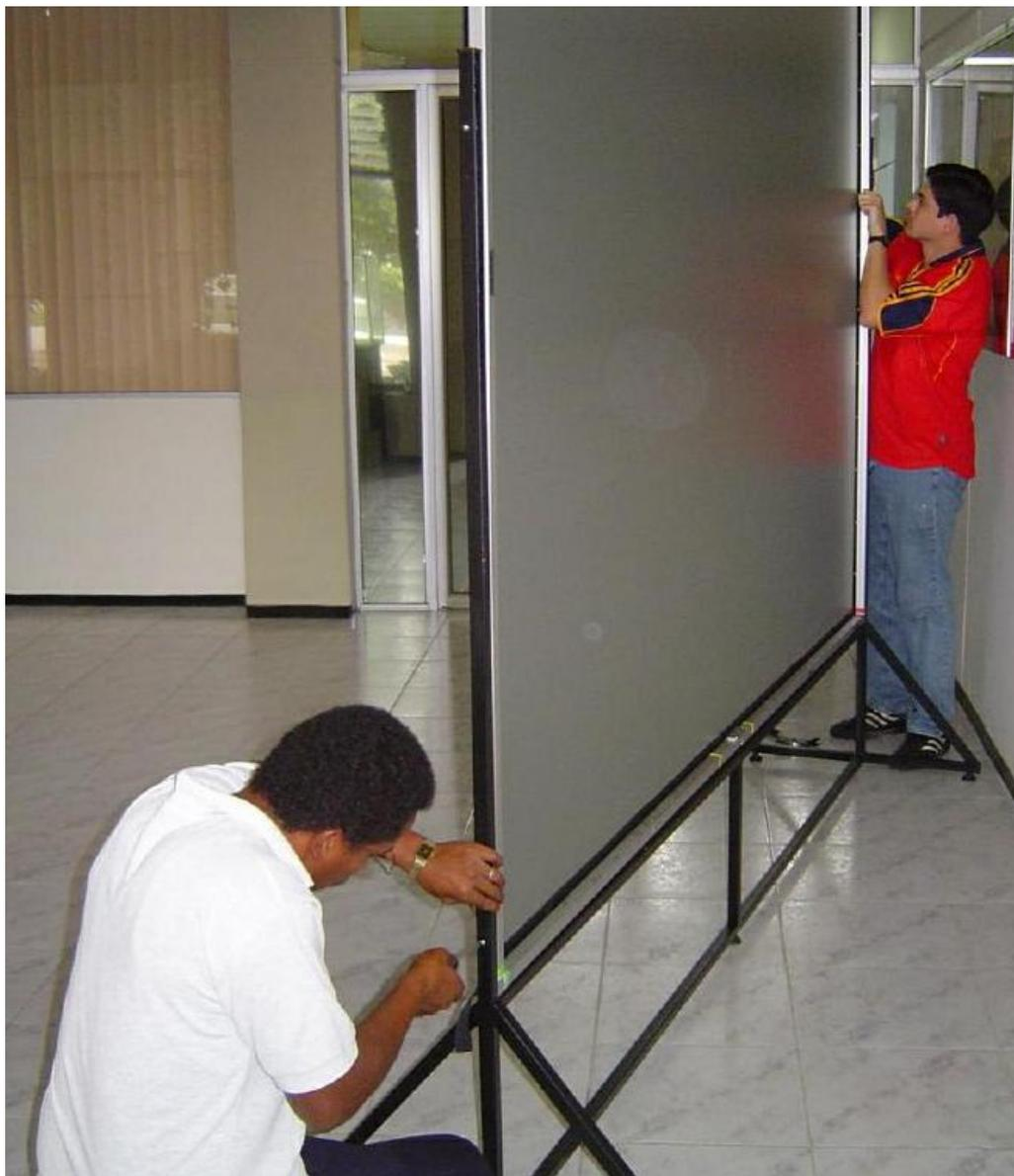
Figura 4-28 Unión de la pantalla con la base
