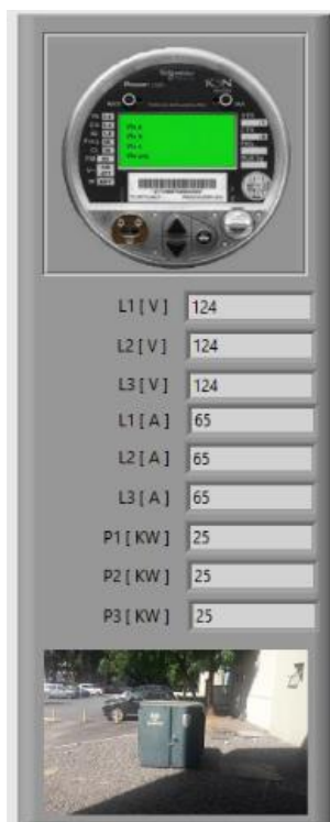
Figura 4.1: Lecturas de mediciones registradas por el medidor principal y observadas en la interfaz del sistema SCADA
