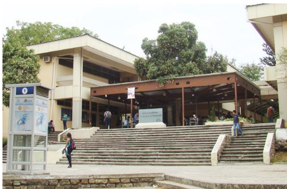
Figura 3.5: Plazoleta del edificio 24 A [9]
