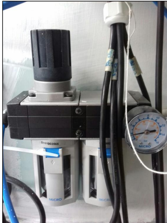
Figura 2.10: Filtro, regulador y lubricador de aire
