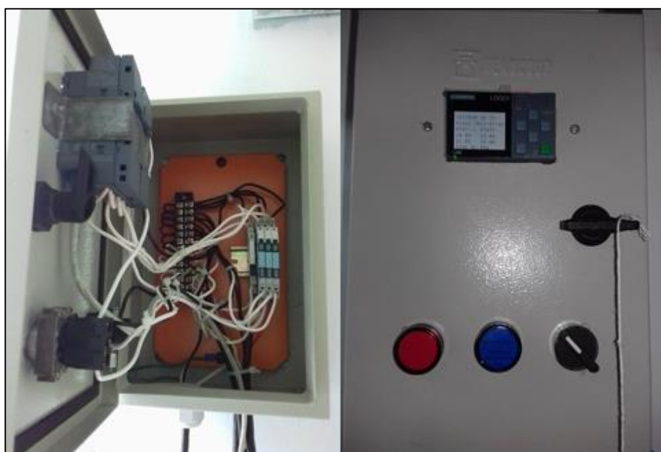
Figura 4.1: Conexiones y Montaje del SIT
