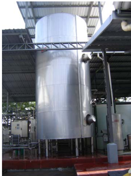
Fig. 2.10 Foto silo de almacenamiento
