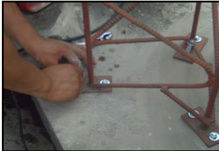
Fig 4.6 Colocación de los Refuerzos de la Torre
