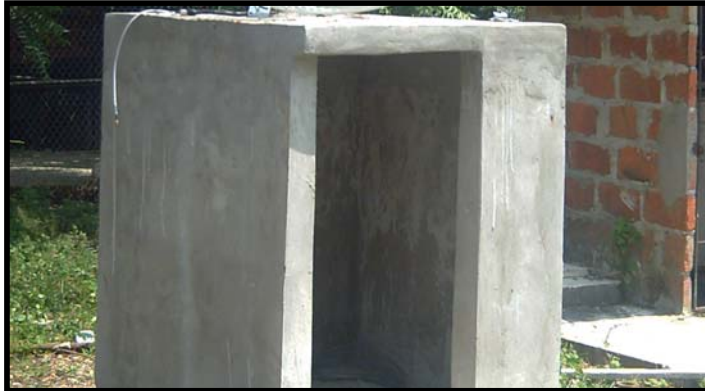
Fig 4.3 Construcción de la Cabina de Equipos
