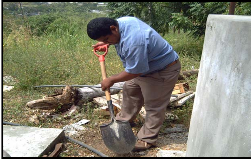
Fig 4.23 Relleno de Tubería Exterior
