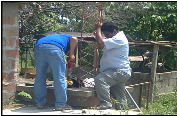
Fig 4.4 Colocación de la Torre
