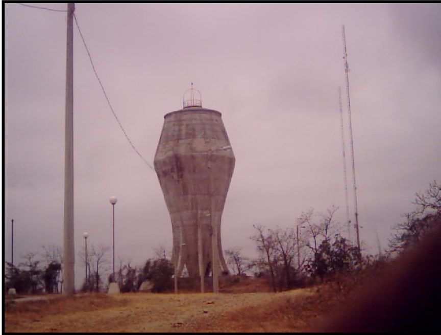
Fig 3.2 Estación de ESPOLTEL junto al Reservorio de Agua
