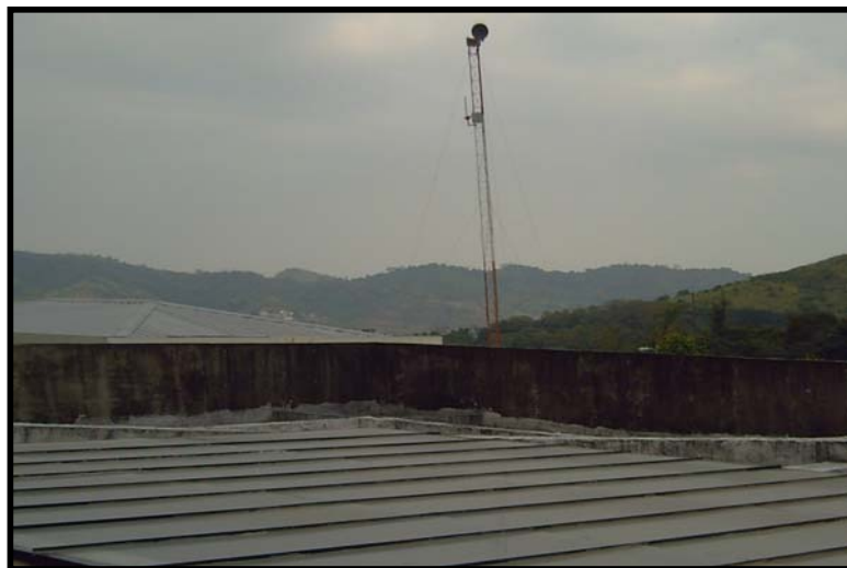
Fig 4.26 Lugar donde será colocada la antena
