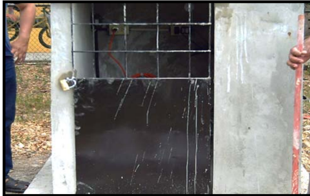
Fig 4.21 Puesta de la Reja en la Cabina de Equipos
