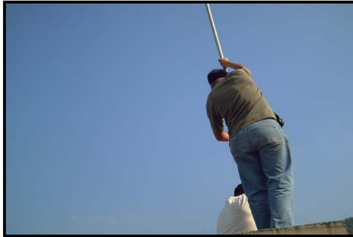
Fig 4.29 Puesta a Punto de la Antena
