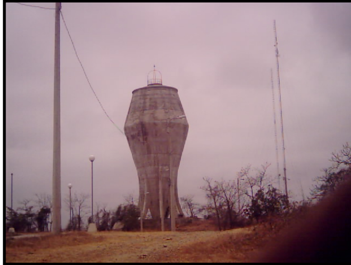
Fig 4.1 Búsqueda de lugar adecuado para la torre
