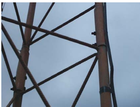
Figura 3.25 Puntos de soldadura de torre
