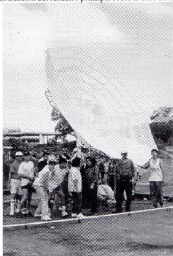
Foto 6.- Instante en el que se están colocando los pernos de fijación de la base de la antena.
