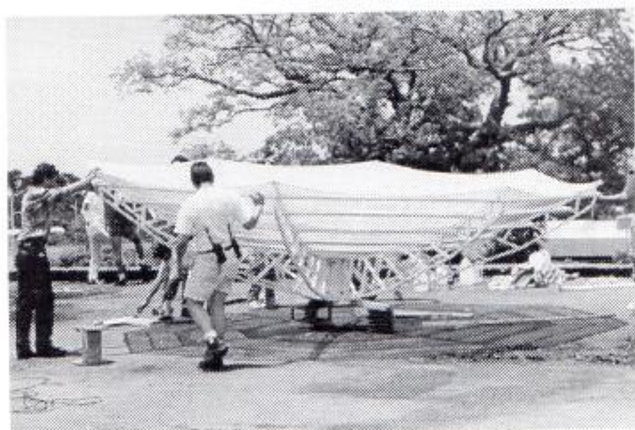
Foto 4.- Reflector principal parabólico completamente armado.
