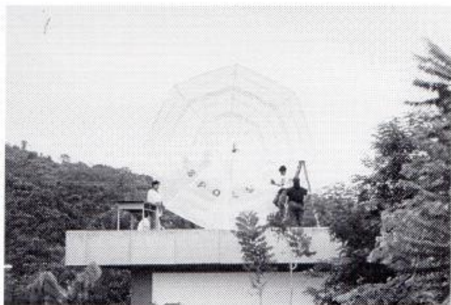
Foto 8 - Antena completamente armada vista desde el patio de la Facultad de Ingeniería Eléctrica y Computación.
