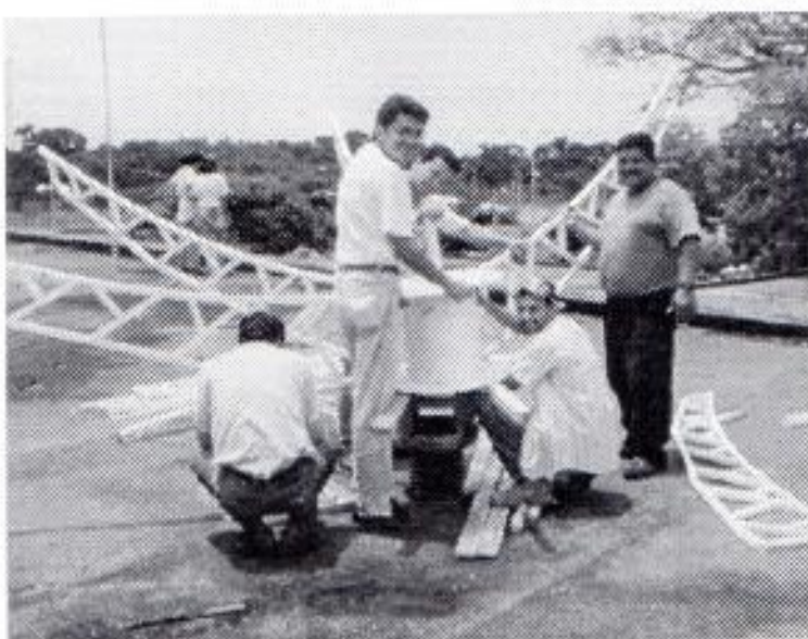
Foto 2.- Colocación de las costillas estructurales. Al mismo tiempo se hacían huecos con taladro sobre la terraza para colocar y fijar los pernos que sujetan la base de la antena.
