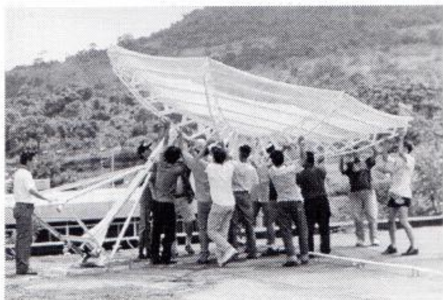
Foto 5.- Colocación del reflector principal sobre la base de la antena.
