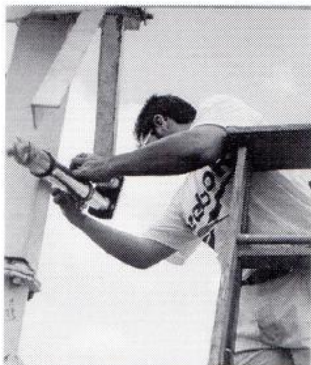
Foto 7.- Momentos cuando se procede a la instalación del actuador (motor y brazo). Luego se realizó la conexión de los cables que comunican el motor con el control del actuador.
