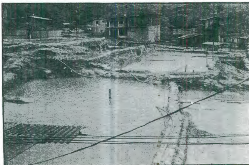
Fig. 2.3. Almacenamiento de Relaves en Piscinas
