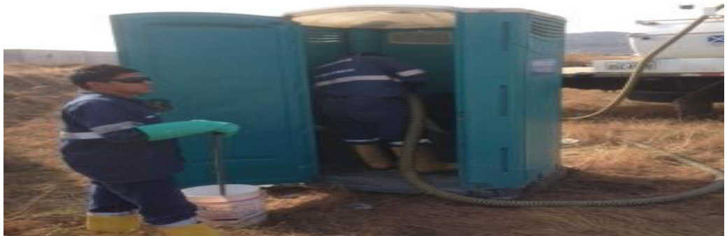
FIGURA 32: LIMPIEZA DE BATERIA SANITARIA.
