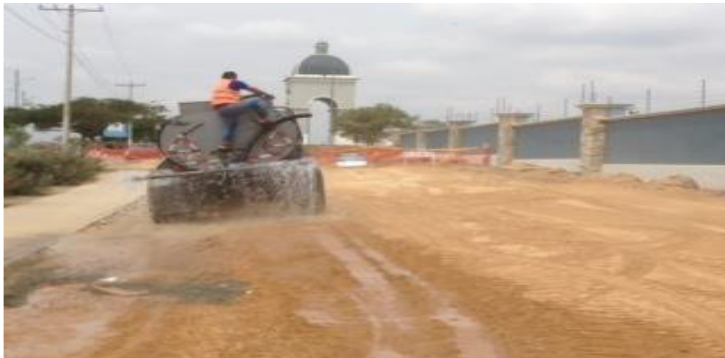
FIGURA 34: CONTROL DE POLVO CON TANQUEROS.
