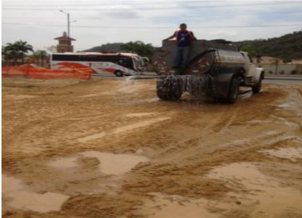
FIGURA 35: CONTROL DE POLVO CON TANQUEROS.
