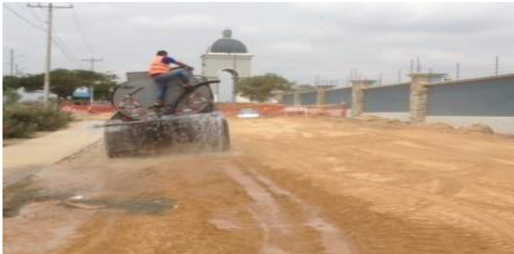
FIGURA 34: CONTROL DE POLVO CON TANQUEROS.
