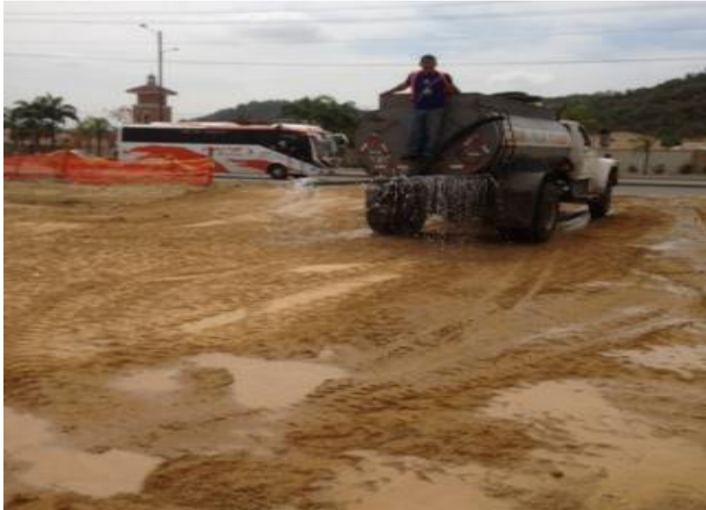
FIGURA 35: CONTROL DE POLVO CON TANQUEROS.
