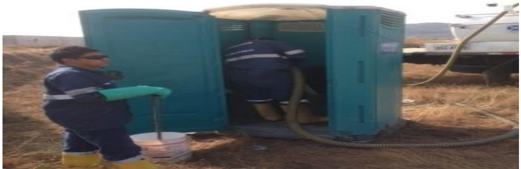
FIGURA 32: LIMPIEZA DE BATERIA SANITARIA.
