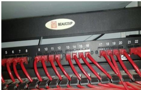
**Figura 6.** Patch Panel de 24 puertos instalado en el Laboratorio
