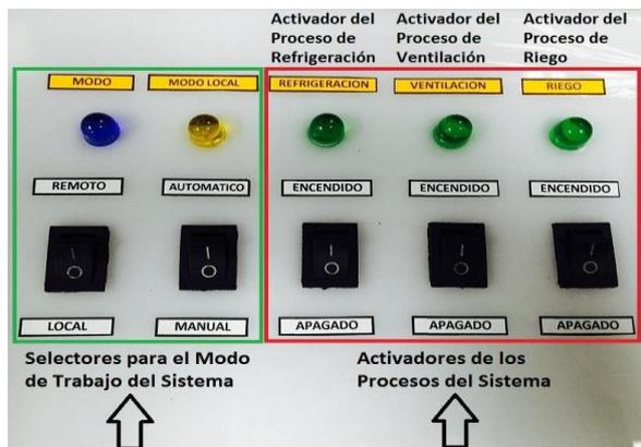
Figura 4.1-Interruptores para activación/desactivación del sistema.
