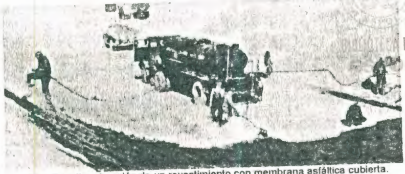
FOTO # 17 Construcción de un revestimiento con membrana asfáltica cubierta.
