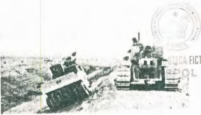
FOTO # 15 Compactación de suelo cemento en un talud lateral.
