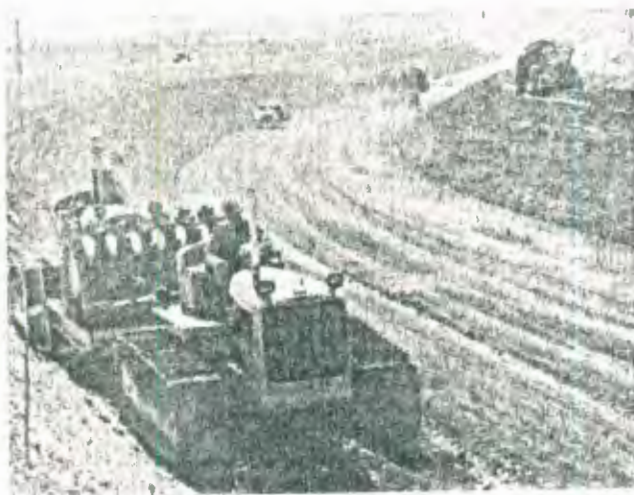
FOTO # 12 Instalación de una capa delgada de revestimiento de tierra en un canal.
