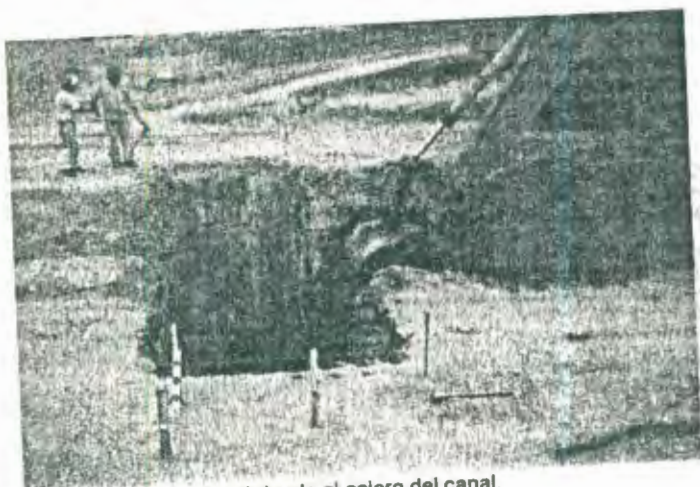
FOTO # 20 Retro excavadora abriendo el cajero del canal.
