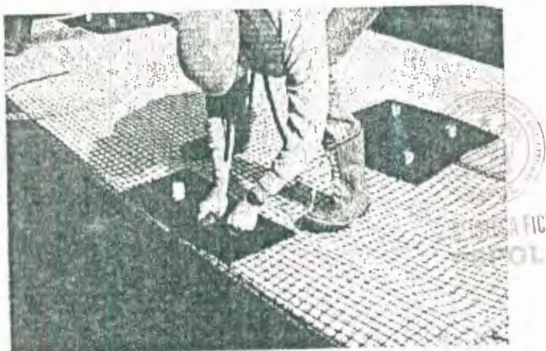
Foto # 3 Instalación del Geogrid.
