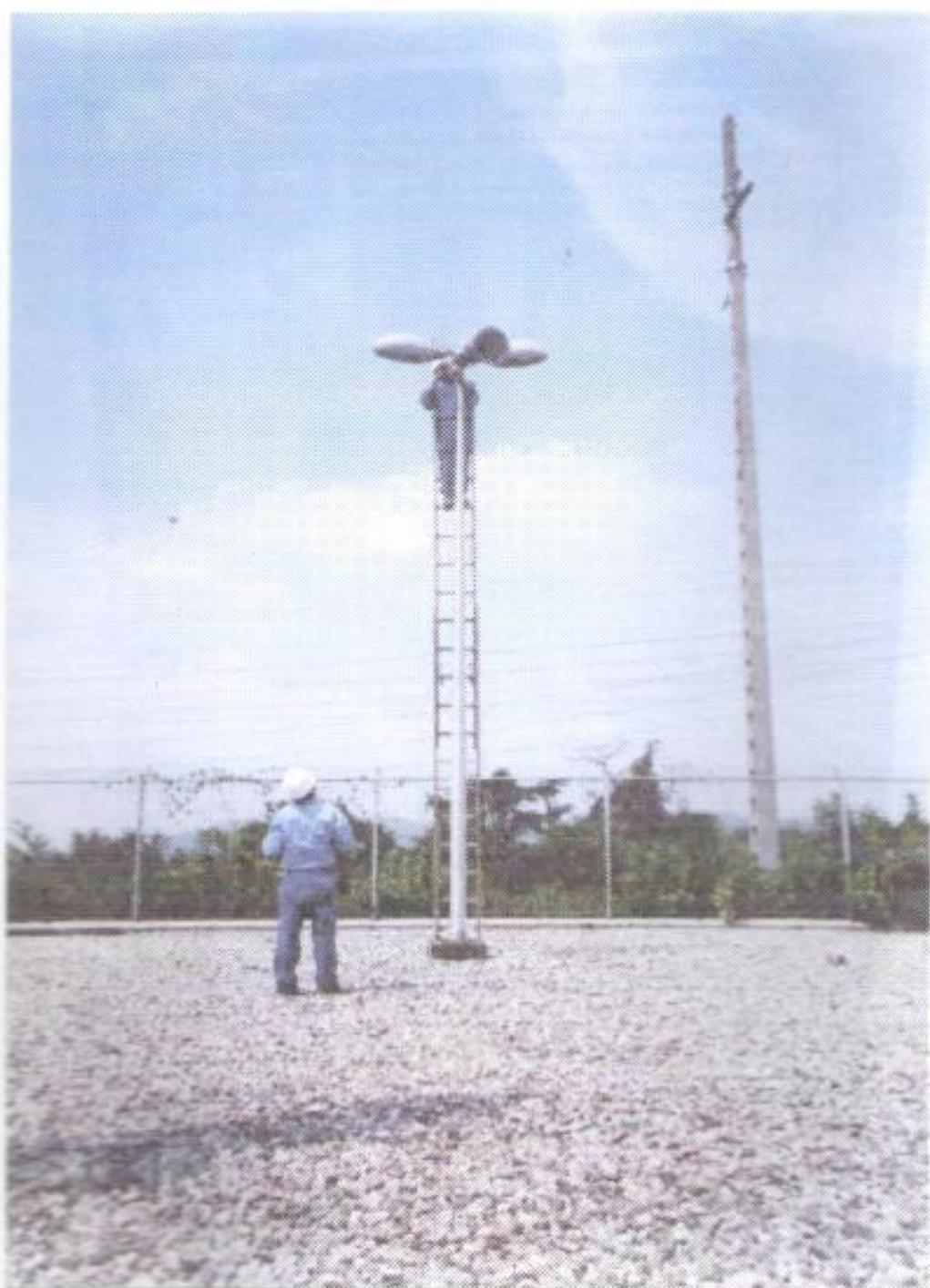
**FIG. 5.21** Mantenimiento preventivo LUMINARIAS patio subestaciones eléctricas
