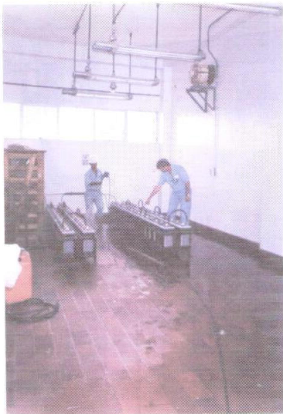
**FIG. 5.19** Mantenimiento preventivo CUARTO de BATERIAS: limpieza general
