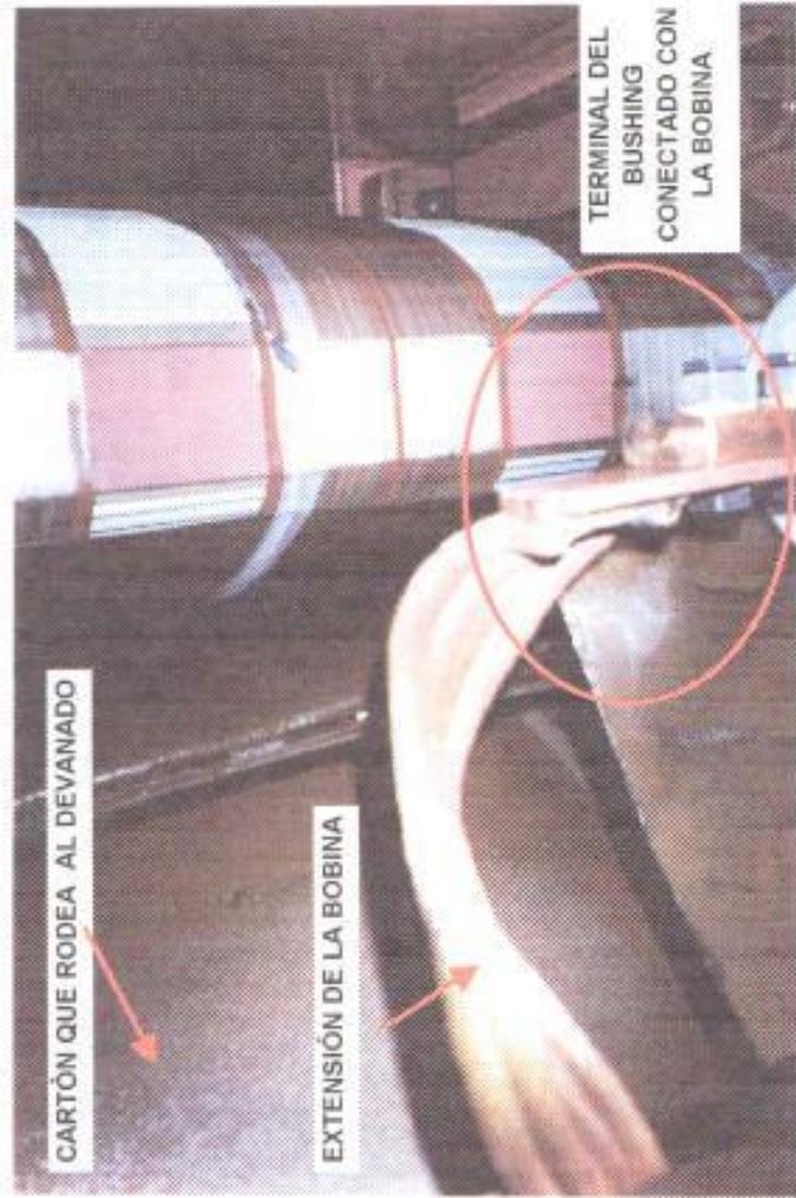
VISTA INTERNA DEL PUNTO DE CONEXIÓN DEL TERMINAL DEL BUSHING CON LA BOBINA O DEVANADO DE 69 KV
