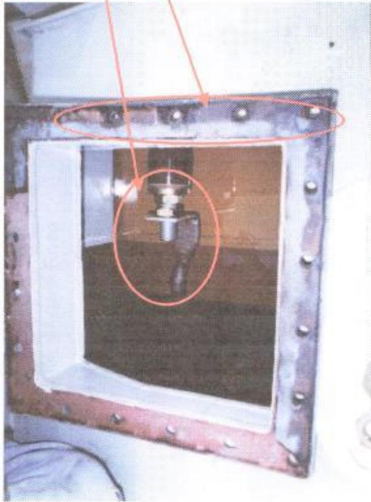
VISTA DE CONEXIÓN INTERNA DEL BUSHING NEUTRO
