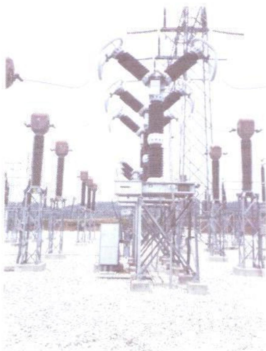
**FIG. 5.2 Disyuntor CENEMESA tipo columna 230 KV S/E Pascuales**
