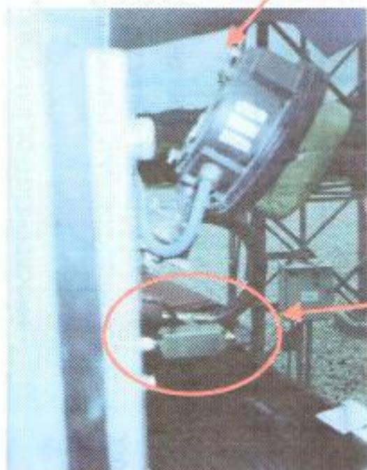
Válvula de control para inyección y extracción del gas SF<sub>6</sub> reemplazada
