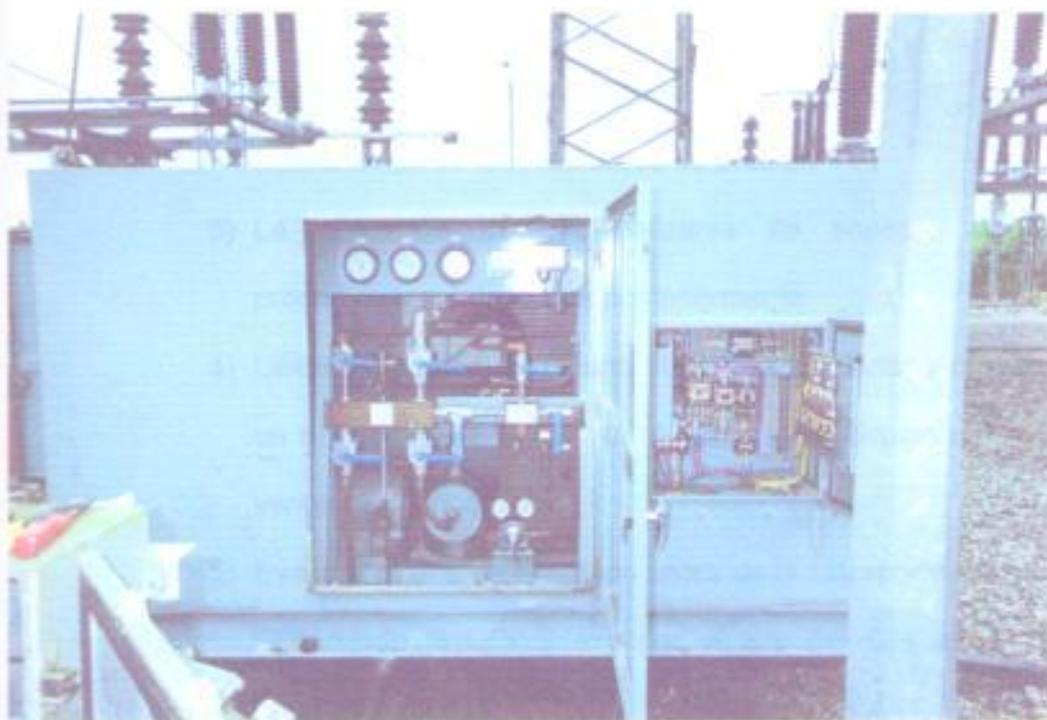
**FIG. 4.17** Vista frontal de la máquina de tratamiento de SF<sub>6</sub>
