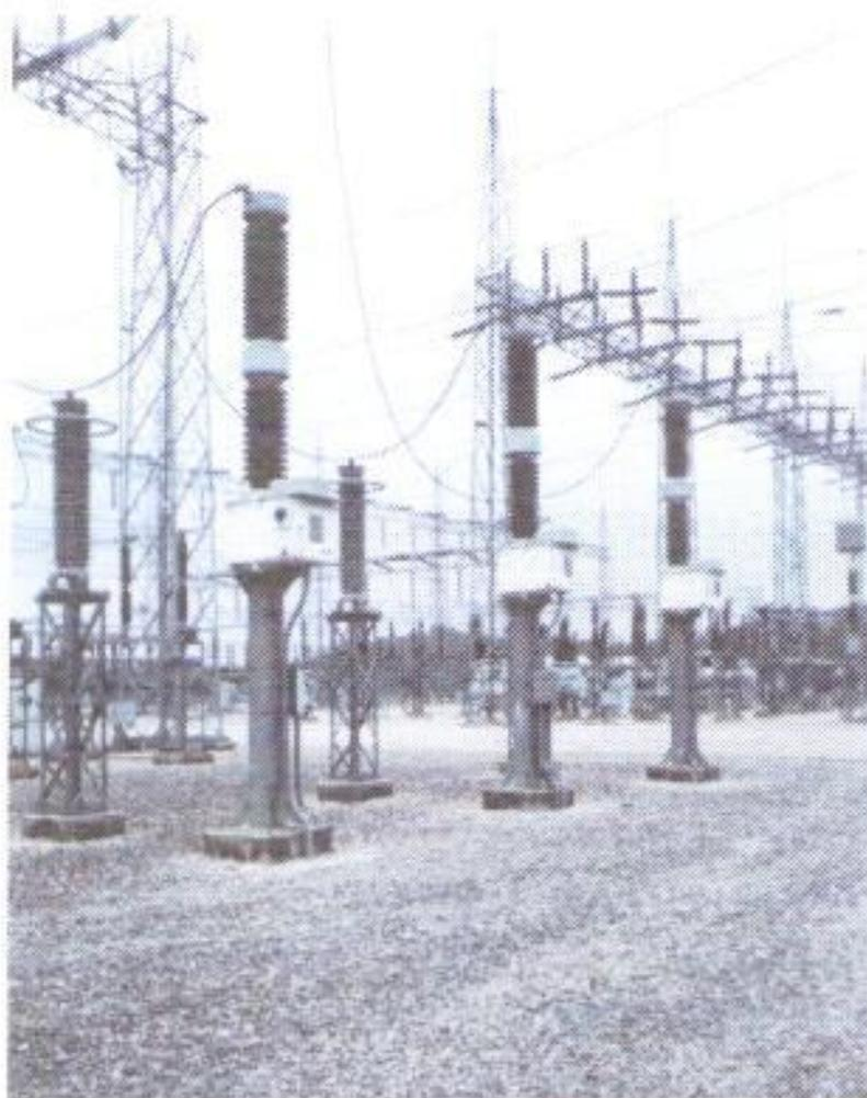
FIG. 5.12 Divisores capacitivos de potencial Nissin Electric 230 KV
