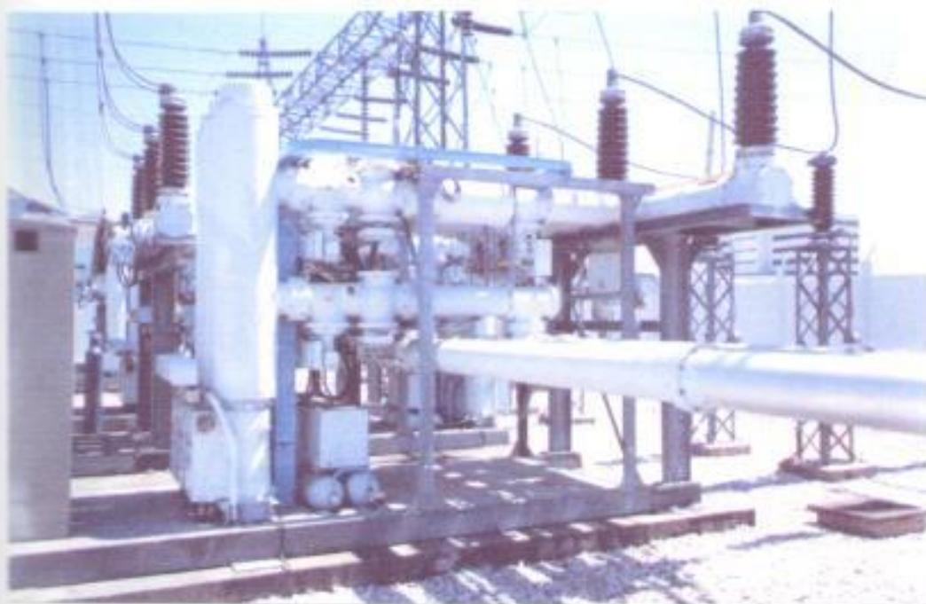
**FIG. 4.1** Posición encapsulada (GIS) a 138 KV Subestación Policentro
