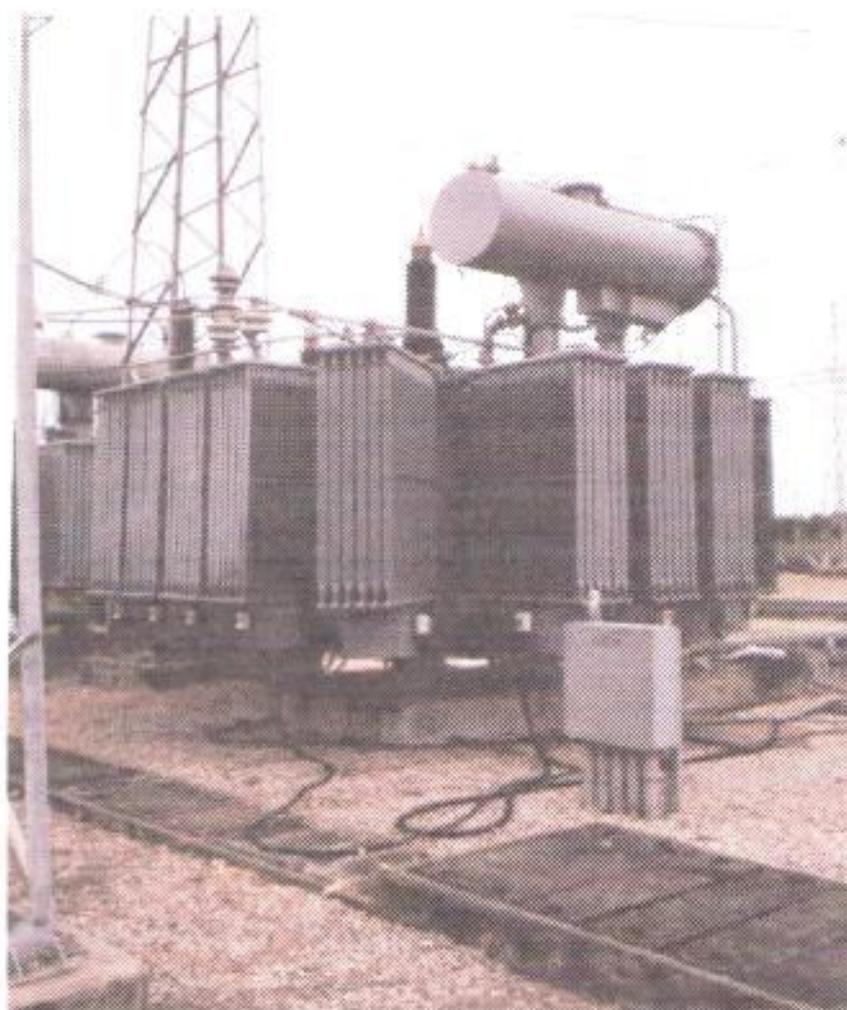
**FIG. 5.14 Autotransformador monofásico 138/69/13.8 KV S/E Salitral**
