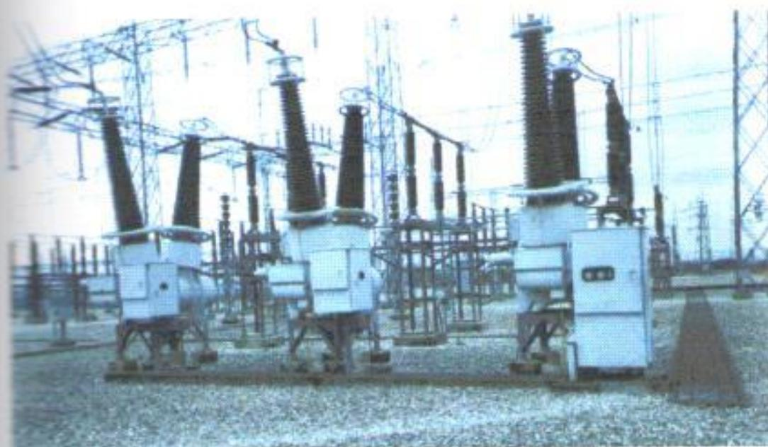
**FIG. 2.3 Disyuntor Mitsubishi en SF<sub>6</sub> tipo PUFFER 230 KV**
