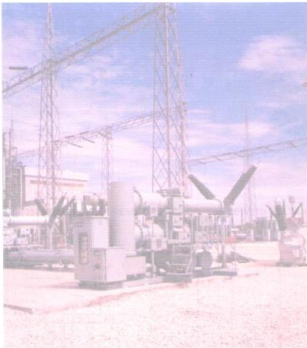
**FIG. 22 VISTA POSICION PVG-2 138 KV GIS MITSUBISHI MONTADA
