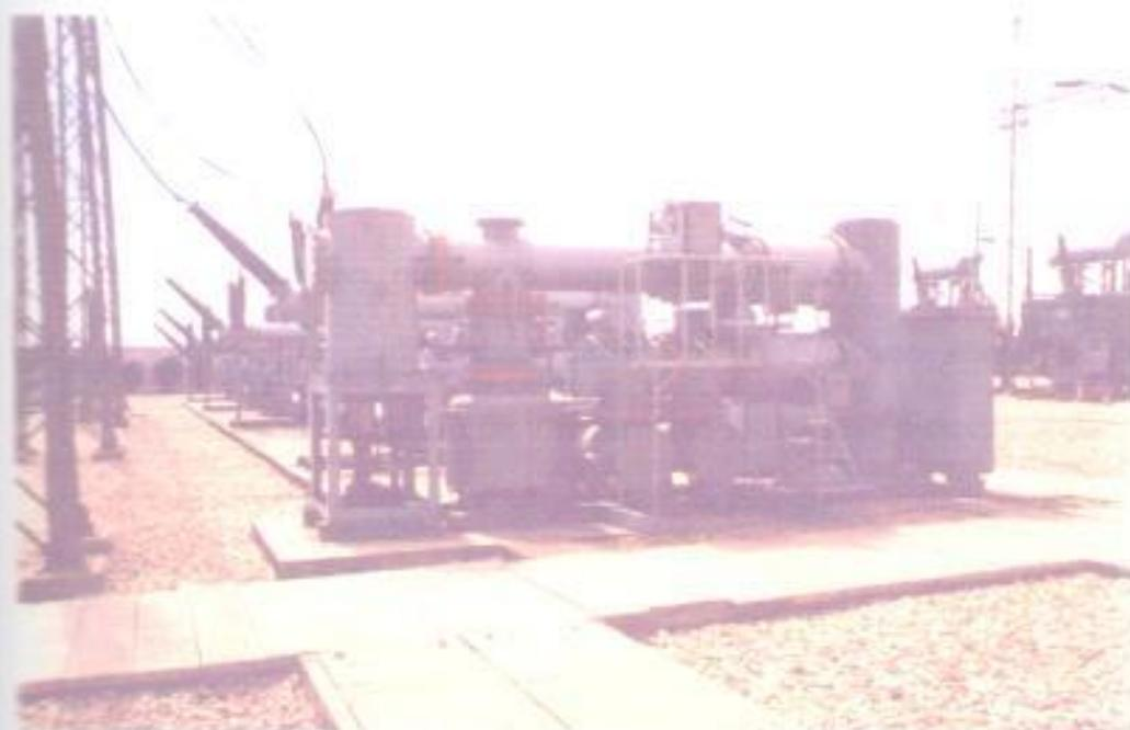
**FIG. 4.3 Posición encapsulada (GIS) 138 KV Subestación Trinitaria**
