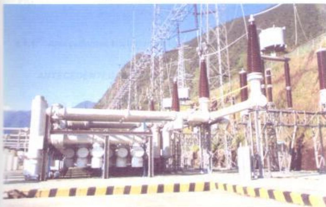
**FIG. 4.2** Posición encapsulada (GIS) a 230KV Subestación Molino
