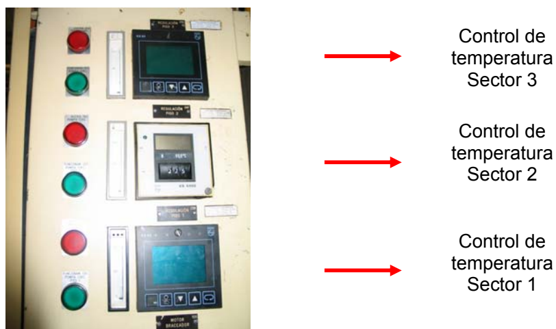
FIG. 3.2 1. CONTROLES DE TEMPERATURA DE SECTORES (TEMPLADORA ASTEED)
