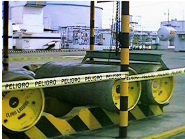
El cloro gas se utiliza para evitar el crecimiento excesivo de algas, conchillas, mejillones, etc., cumple la función de bactericida, para impedir su anidación de estos en los tubos del agua de circulación. Si este proceso no se realiza esto conllevaría a que el diámetro de las tuberías se reduzcan así como también se llegue a una baja transferencia de calor del vapor a condensar hacia el agua salada de enfriamiento.
