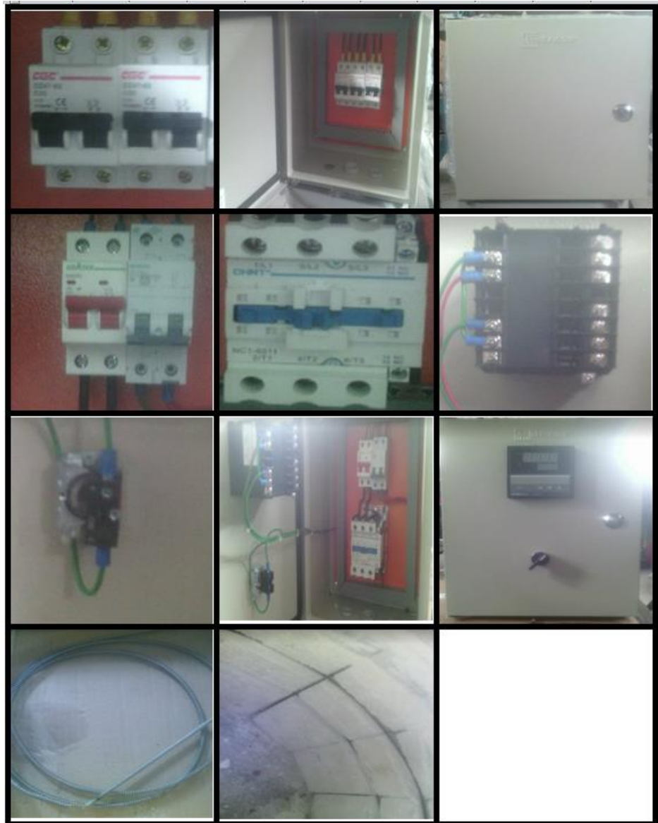
Figura 3.10 Construcción de sistema electrico
