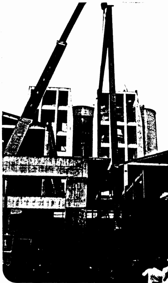
FIG. 3.16.- MONTAJE DEL PRIMER PORTICO DEL PRECIPITADOR ELECTROSTATICO.
